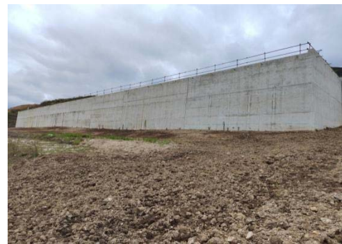
开关站挡土墙
