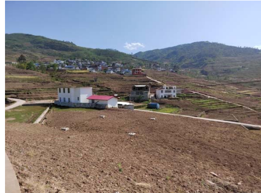
尔足-甘洛南 J9 号铁塔塔基施工场地复耕
