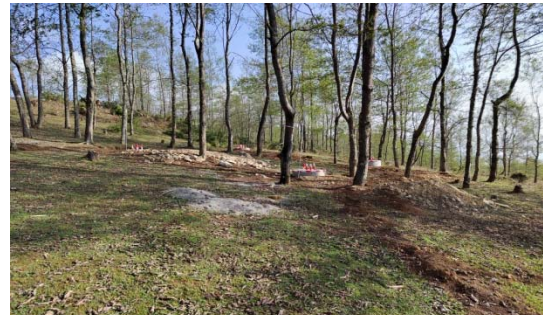
相岭-蓼坪 N218 号塔基余土平整
