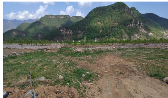
相岭-蓼坪 N101 号塔基施工场地复耕
