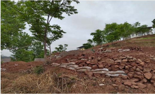
尔足-蓼坪 JB6 号铁塔临时拦挡
