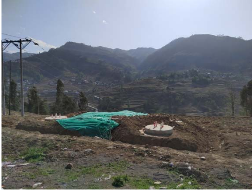
蓼坪-甘洛南 JA1 号临时遮盖
