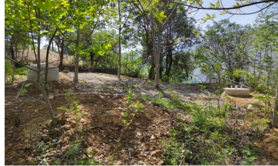
蓼坪-甘洛南 ZA19 号余土平整
