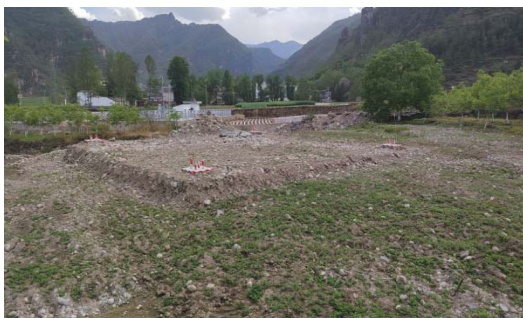
相岭-蓼坪 N100 号塔基及施工场地平整
