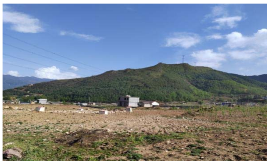
相岭-蓼坪 J201 号塔基施工场地复耕
