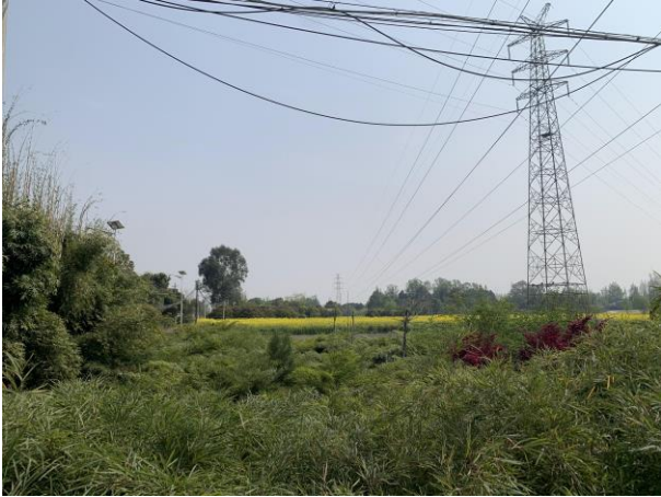
(1) 线路沿线地貌、植被
