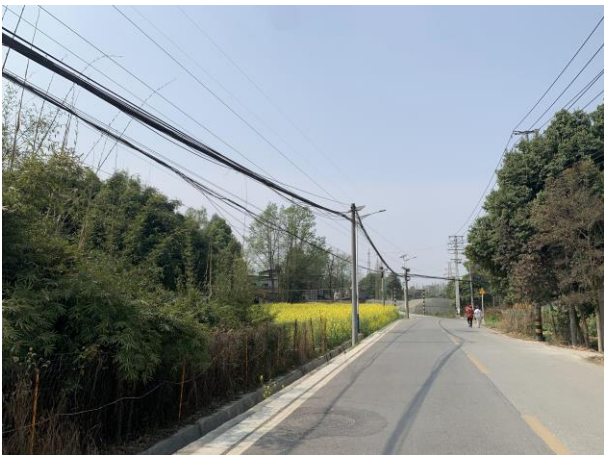
(5) 线路沿线地貌、植被、交通
