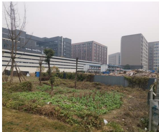
站外施工场地现状
