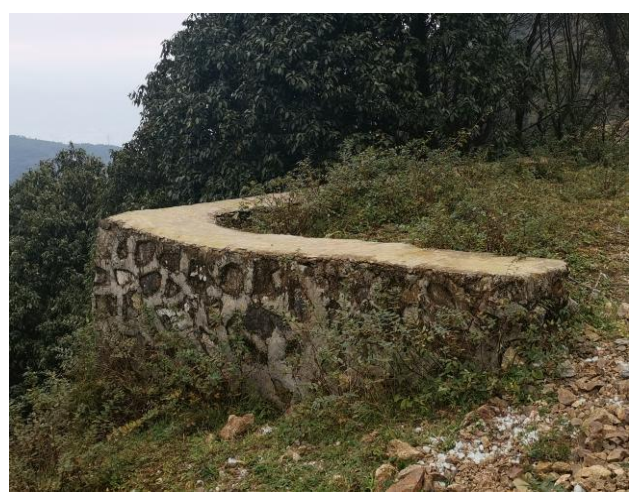
浆砌石挡土墙
