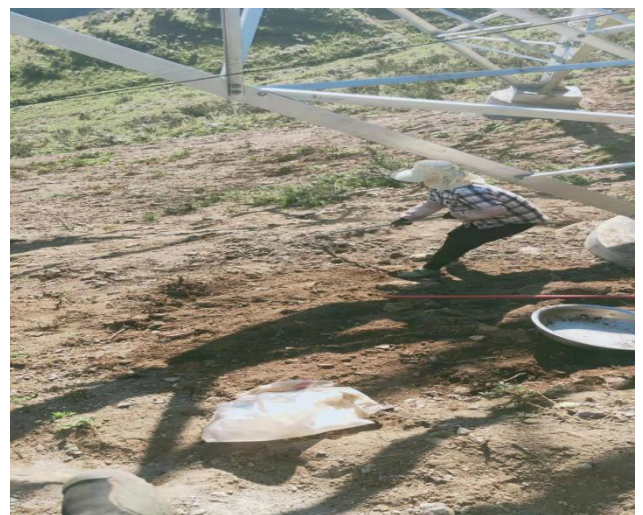
塔基区域土地整治、撒播草籽
