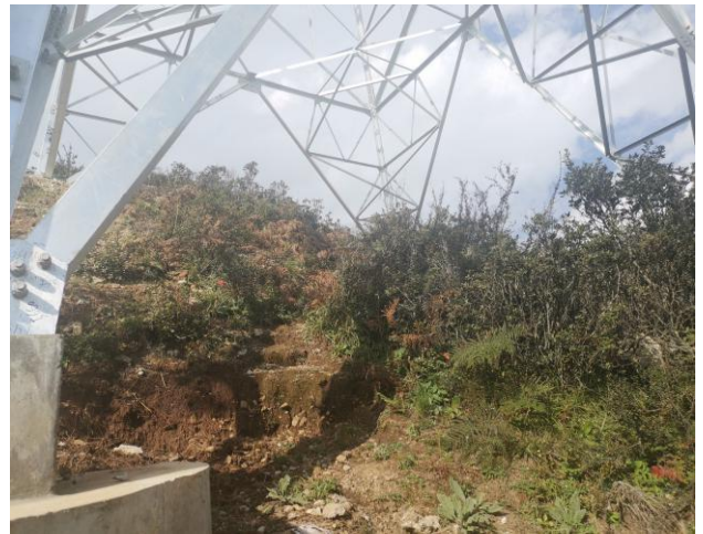
JN130A 塔位植被恢复
