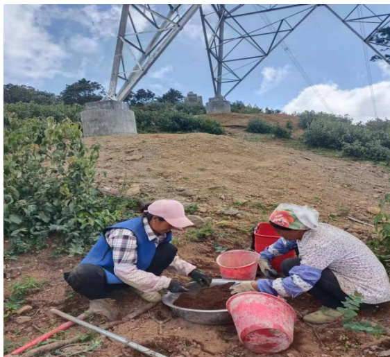
塔基区域土地整治、撒播草籽
