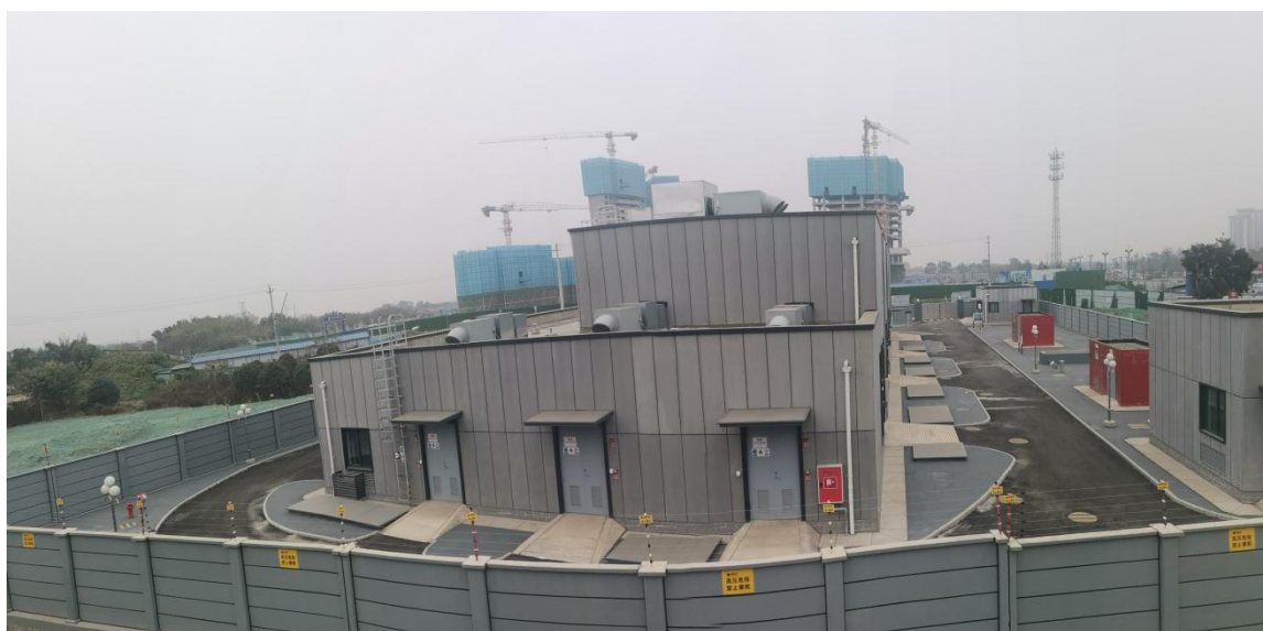
变电站内部现状
