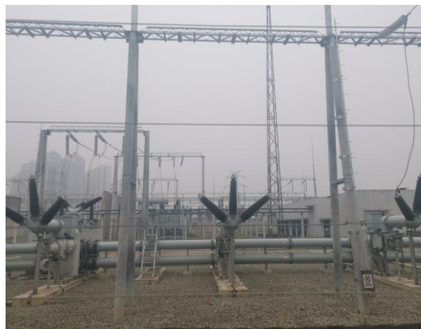
大面变电站间隔扩建区域现状
