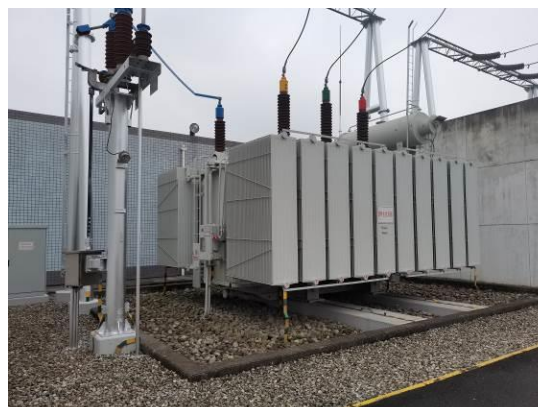
图 3-4 2#主变集油坑
