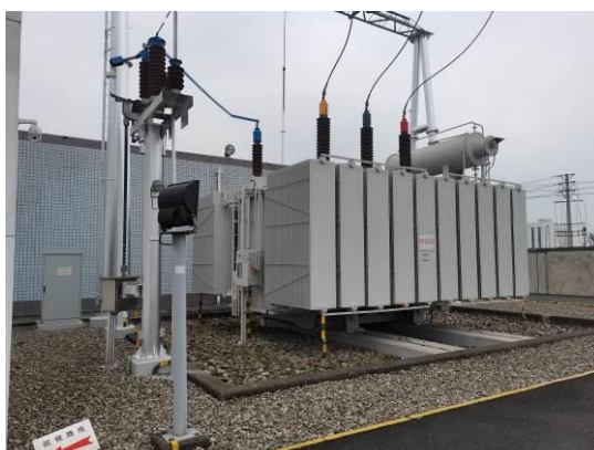
图 3-3 1#主变集油坑
