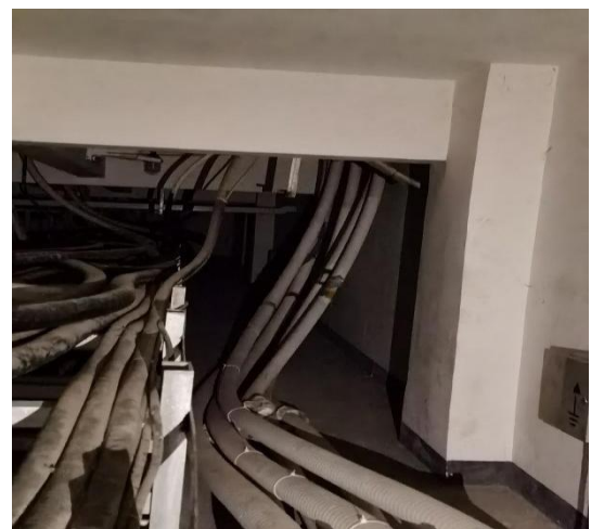
天健变电站内电缆夹层
