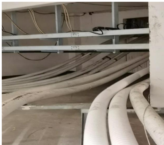
天健变电站内电缆夹层
