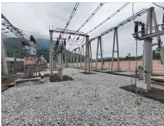
原有变电站砾石压盖
