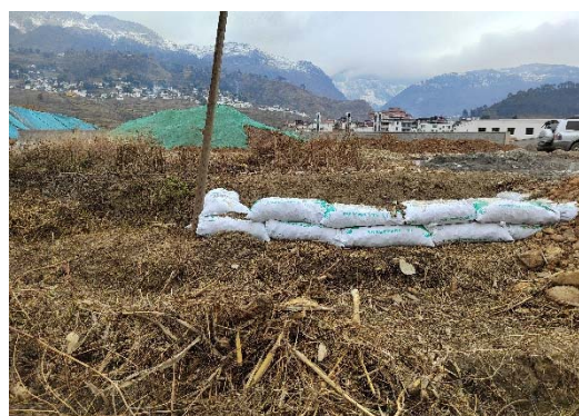
尔足-甘洛南 J15 号铁塔临时拦挡
