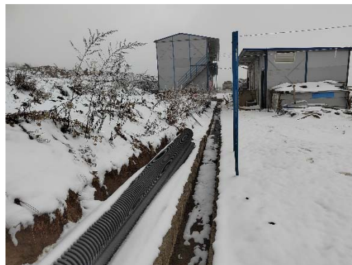
开关站施工临建区临时排水沟
