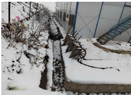
开关站施工临建区临时排水沟
