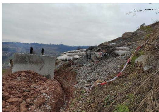
尔足-蓼坪 JB6 号铁塔临时拦挡
