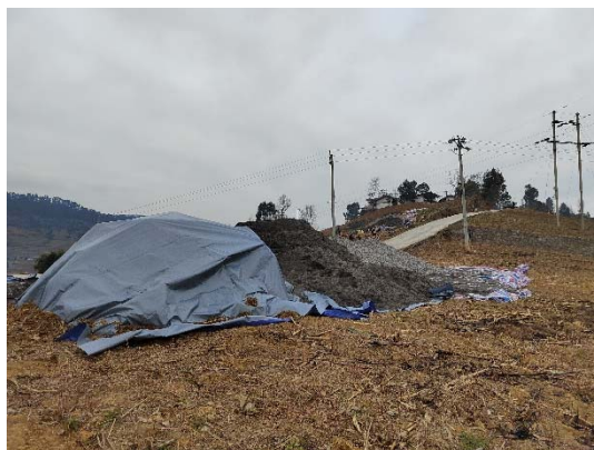
尔足-甘洛南 J10 号塔施工场地临时遮盖隔离
