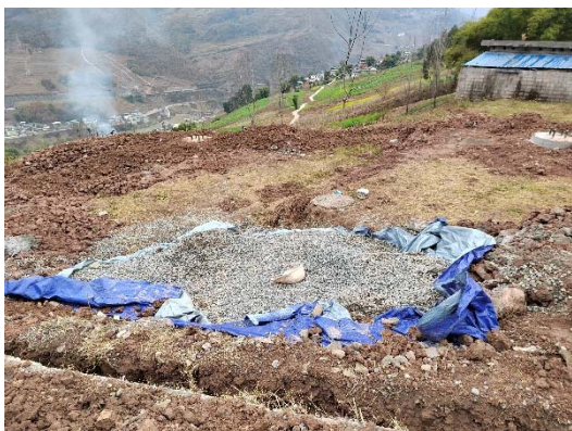
尔足-蓼坪 JB4 号铁塔临时隔离
