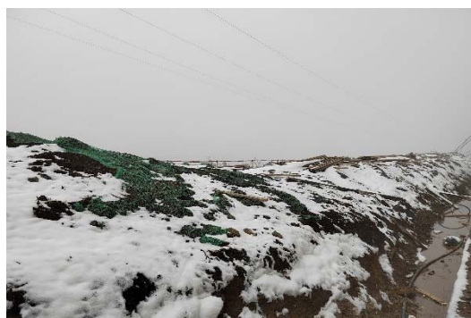
开关站临时堆土临时防护
