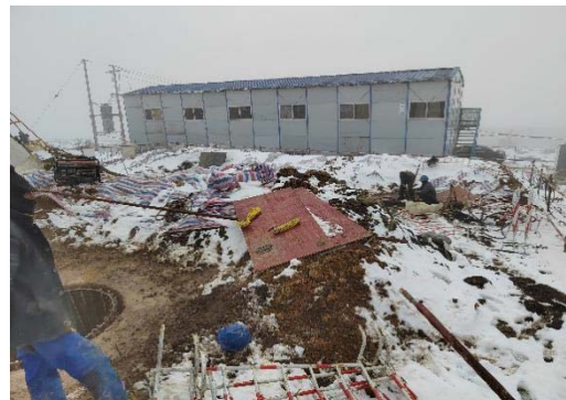
尔足-蓼坪 JB32 号塔表土临时遮盖
