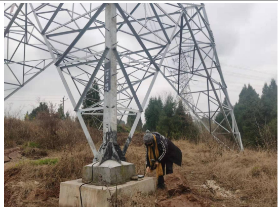
南部～龙华寺线路 34#塔现场监测
