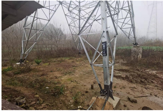
南部～龙华寺线路 23#塔植被恢复
