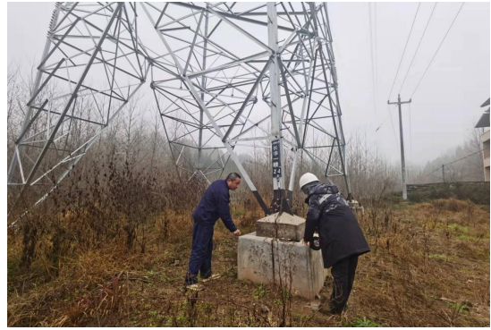
南部～龙华寺线路 24#塔现场监测
