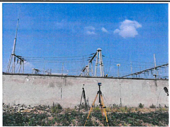
罗盘山 220kV 变电站西南侧厂界处 电磁环境、声环境昼间监测
