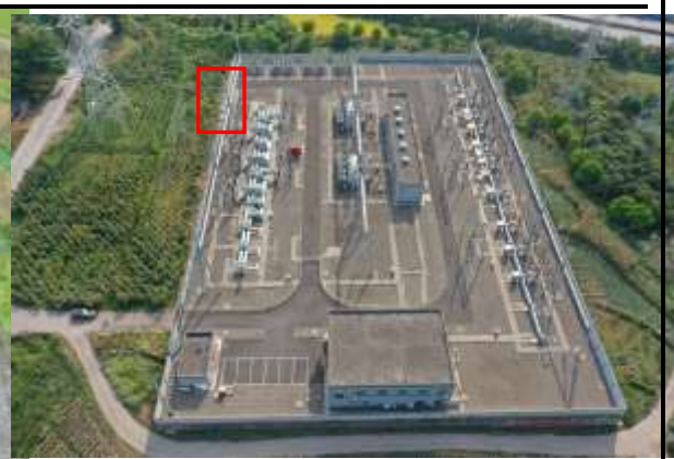
罗盘山 220kV 变电站本项目出线间隔航拍图 (红色框线)
