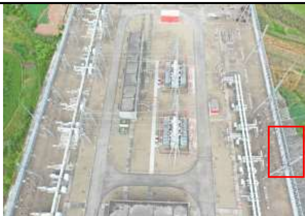
琵琶 220kV 变电站出线本项目间隔航拍图 (红色框线)
