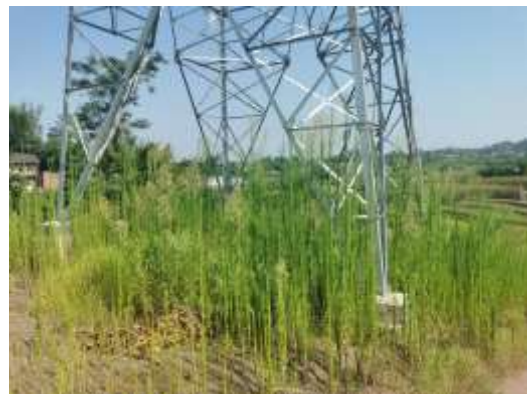
佛沙线 N14 号铁塔（高低腿）
