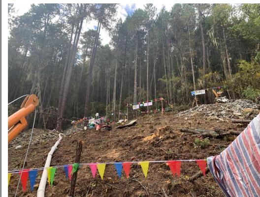
N65 塔斜坡塔位施工前划定扰动区域
