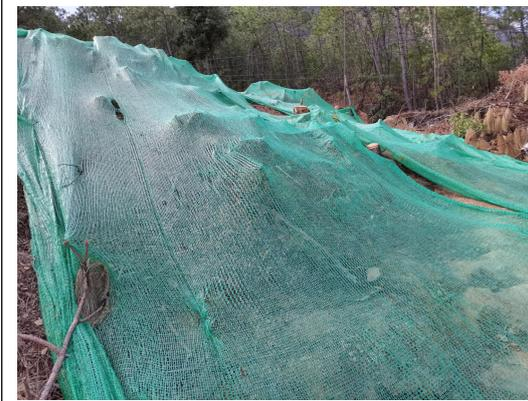
塔基施工表土剥离堆放
