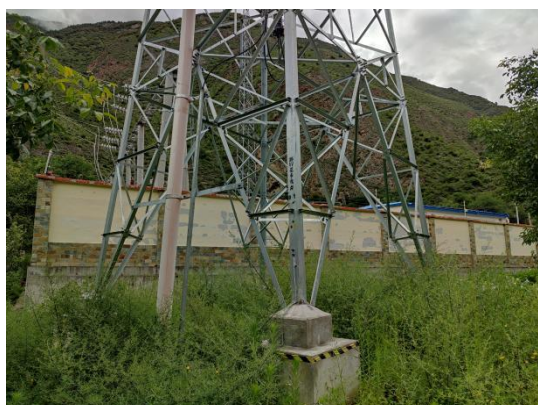
塔基底部绿化恢复
