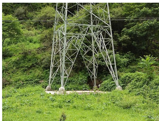
塔基底部防护及绿化
