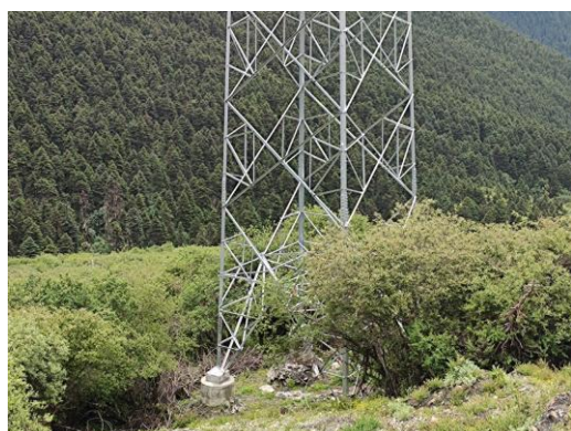
塔基底部绿化恢复
