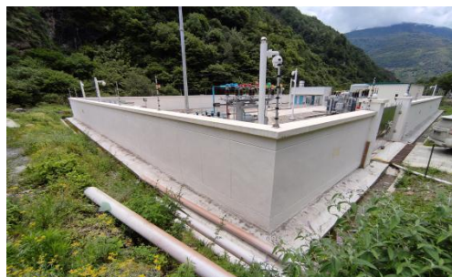
站外排水管及排水沟
