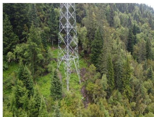
塔基底部绿化恢复
