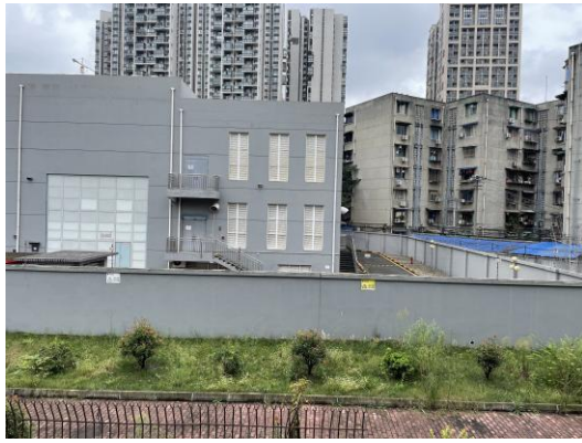
图 19 府青路 110kV 变电改造为户内站
