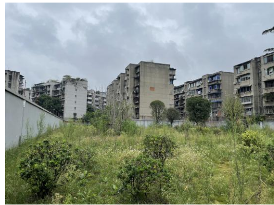
图 22 变电站北侧绿化隔离带
