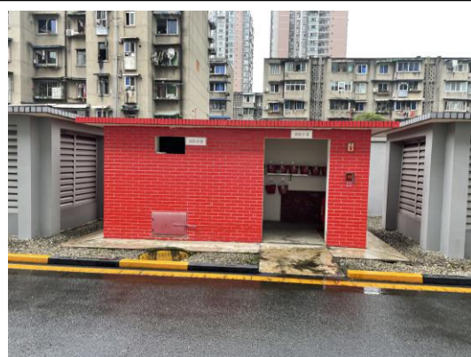
图 25 府青路变电站站内消防小室
