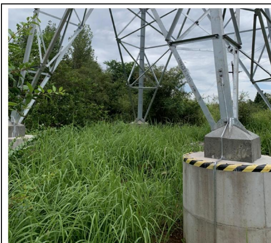
12 号塔 (N7) 植被恢复情况
