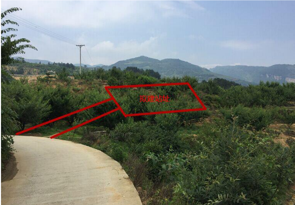
赤水 35kV 变电站位置
