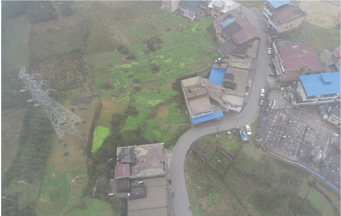
摩尼 110kV 变电站出线通道
