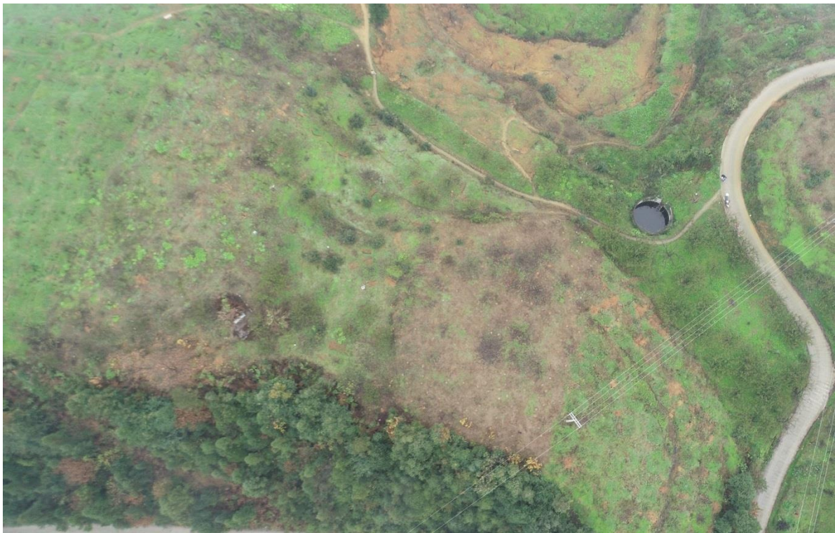
赤水 35kV 变电站位置
