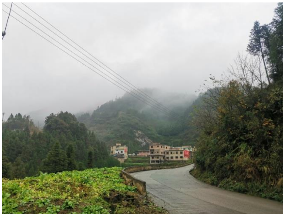
线路沿线交通情况
