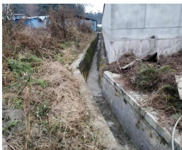
站外排水沟情况
