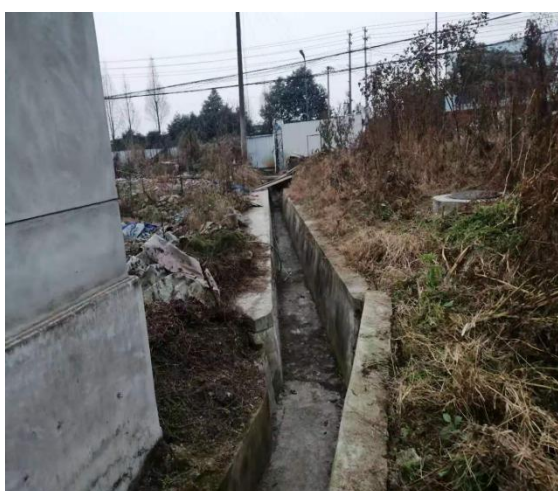
站外排水沟情况
