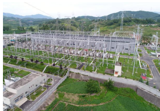
普提 500kV 变电站改造区现状
