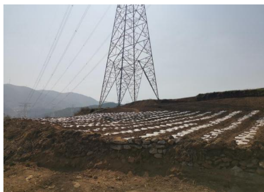
ABN101 号铁塔施工道路复耕
