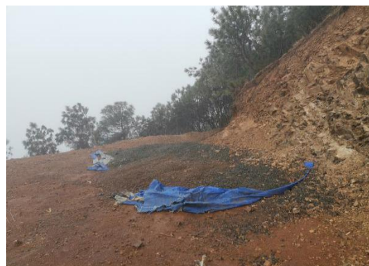
施工材料防雨布隔离
