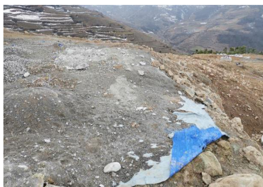
施工材料防雨布隔离
