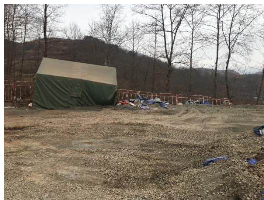
索道站硬质围栏限界、防雨布隔离覆盖
