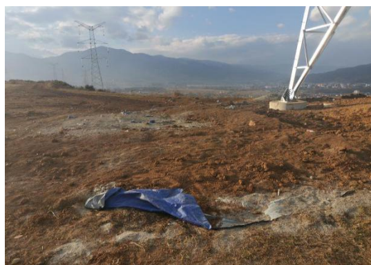
施工材料防雨布隔离
