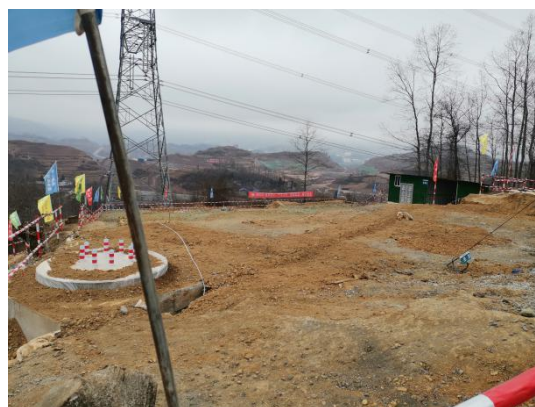
ABN001 号铁塔硬质围栏限界、土地平整
