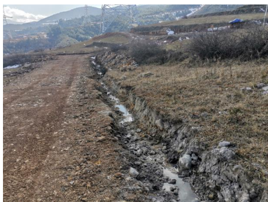
施工道路临时排水沟
