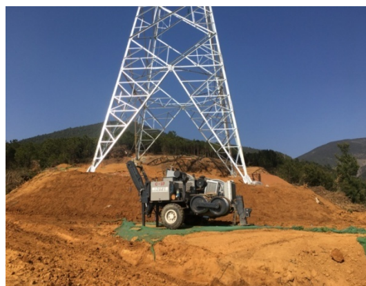
N72(JR24) 号塔施工场地临时隔离
