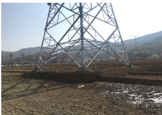
N5 号铁塔施工场地复耕
