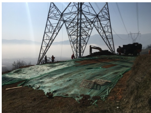
N74(J24) 号塔施工场地临时隔离
