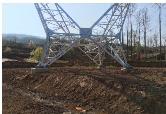
N7 (JR5) 号铁塔施工场地复耕
