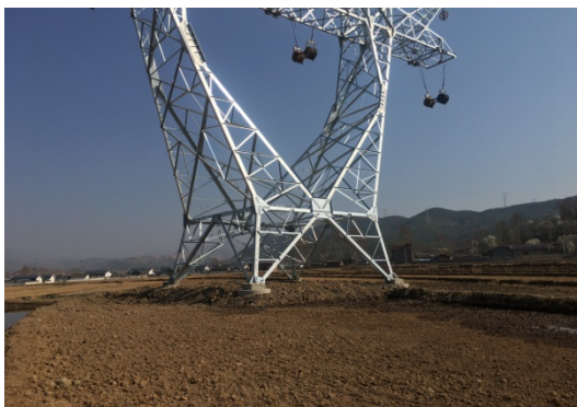
N6 (JR4)号塔施工场地复耕
