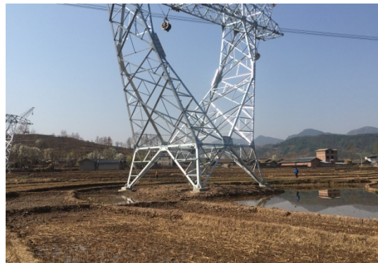
N6 (JL4)号塔施工场地复耕
