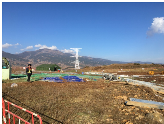
N91 号塔施工场地围栏及临时隔离
