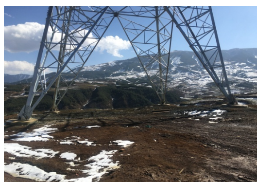
ZNR83 号铁塔施场地整理
