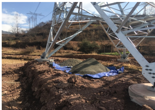
N7 号塔防雨布临时隔离
