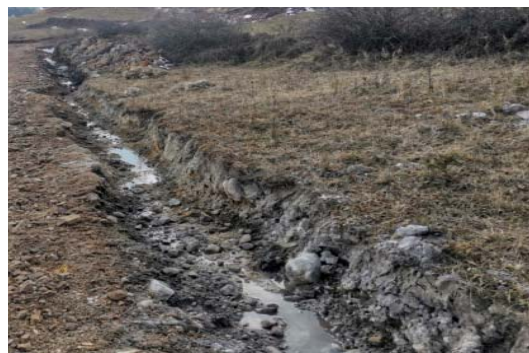
N72 号塔施工道路临时排水沟
