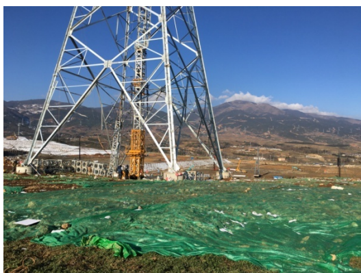
N92 号铁塔临时遮盖
