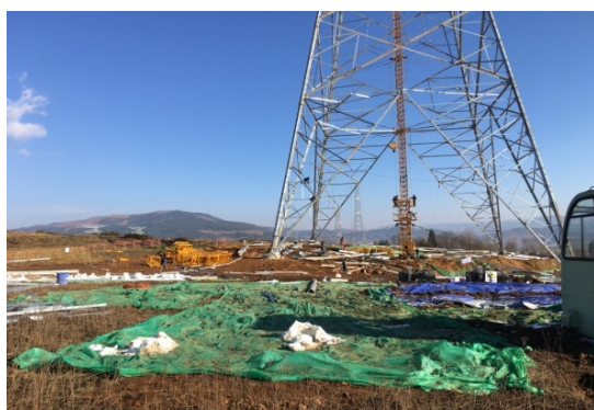
N90 号铁塔临时遮盖
