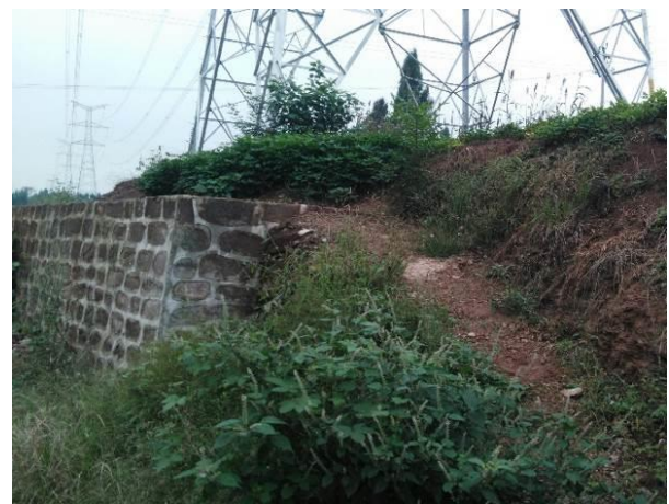
4#-3 监测点, 287 (N4039) 塔基, 2017.9
