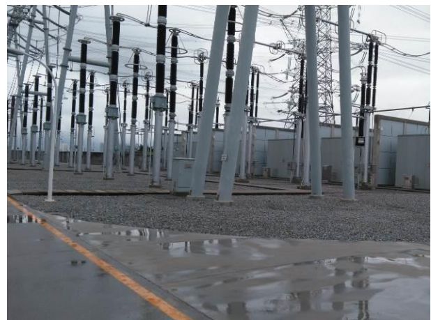
思源变扩建区碎石铺垫后（2017.10）
