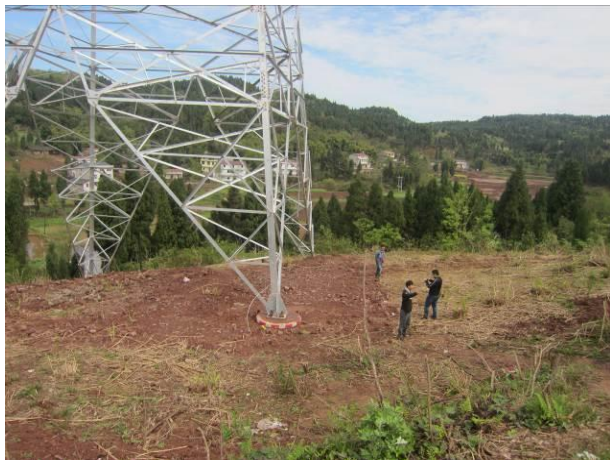
塔基施工面貌（四川段2标，2017.3）
