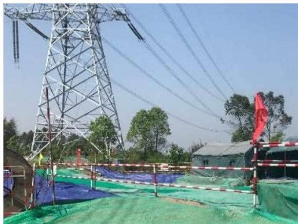
4#-2 监测点, 307 (N4059) 塔基, 2017.5
