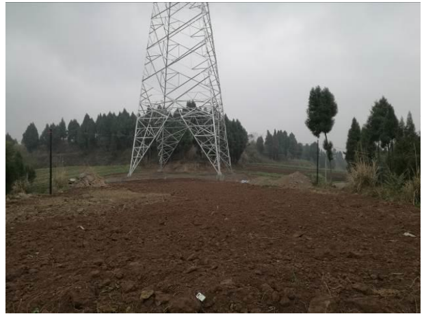
塔基施工面貌（四川段1标，2017.3）
