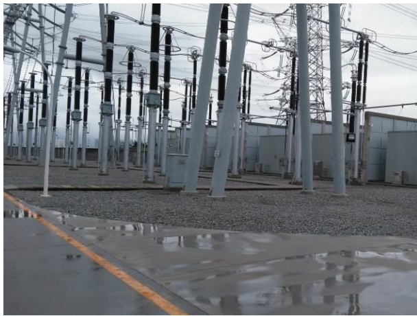
思源变扩建区面貌（2017.10）
