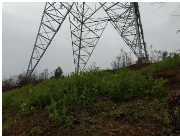
塔基面貌（四川段2标，2019.2）
