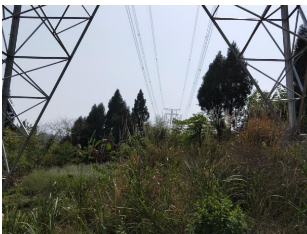
3#-3监测点, 041 (N1042) 塔基, 2018.4
