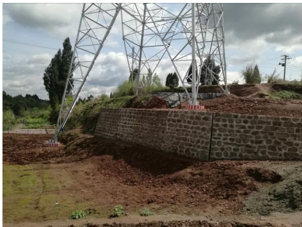
塔基施工面貌及挡墙（重庆段，2017.3）
