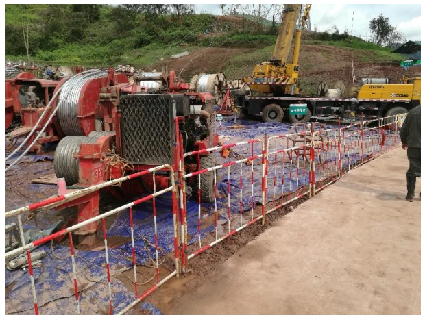
牵张场施工面貌（重庆段，2017.3）
