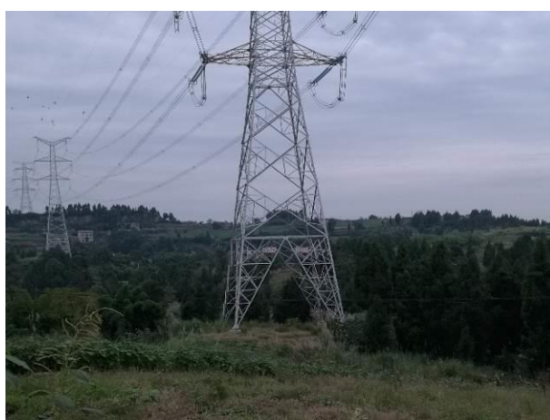
3#-3监测点, 041 (N1042) 塔基, 2017.11
