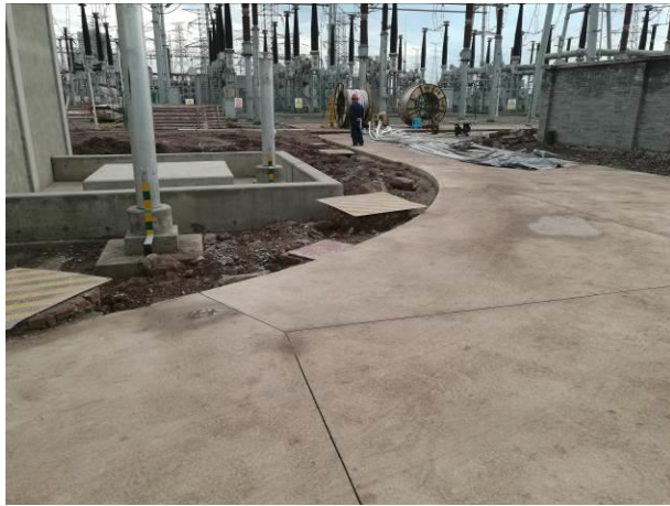
思源变扩建区施工面貌（2017.3）
