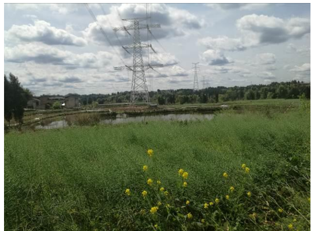
塔基施工面貌（重庆段，2017.3）
