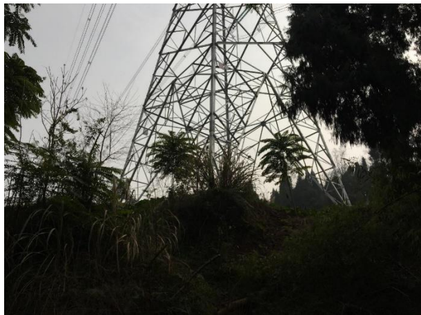
塔基面貌（四川段2标，2019.5）
