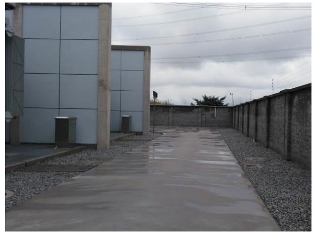
思源变扩建区面貌（2017.10）
