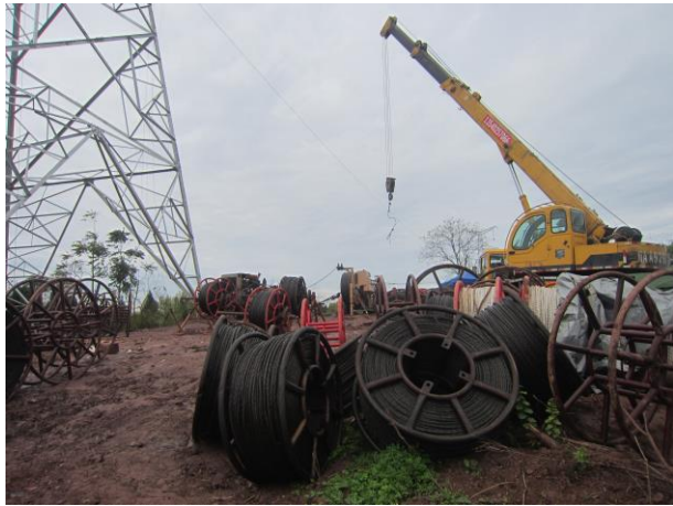
牵张场施工面貌（四川段2标，2017.3）
