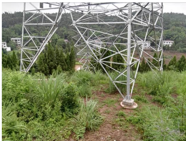
塔基面貌（四川段2标，2017.7）
