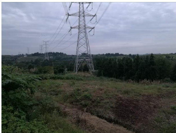
塔基面貌（四川段1标，2017.10）
