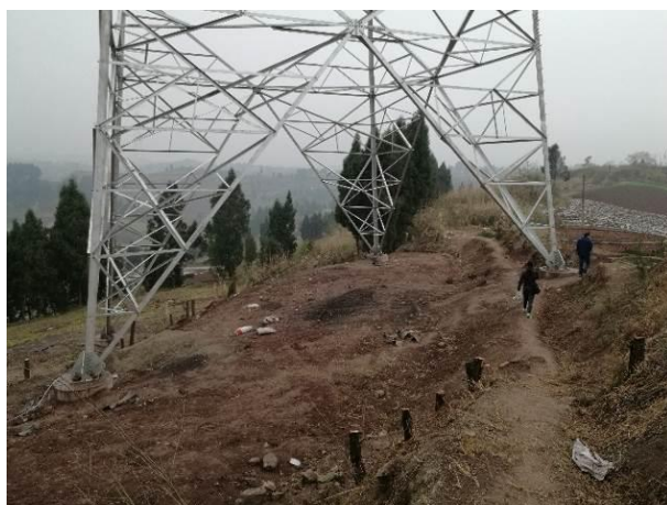
3#-1监测点, 039 (N1040) 塔基, 2017.3
