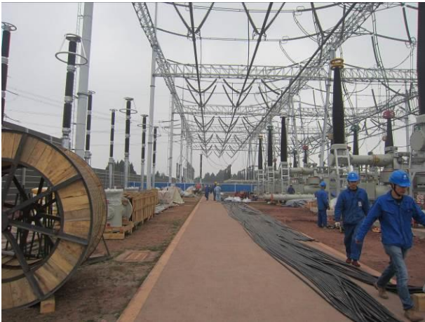
资阳变扩建区施工面貌（2017.3）
