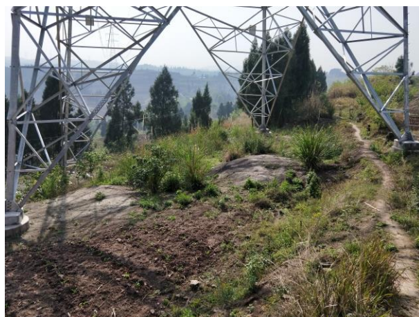
3#-1监测点, 039 (N1040) 塔基, 2018.4
