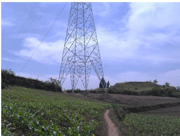
3#-2监测点, 040 (N1041) 塔基, 2017.5
