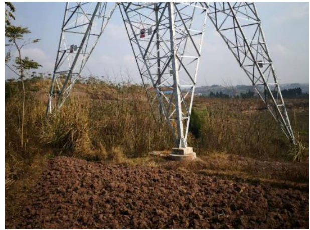
塔基面貌（四川段1标，2019.1）
