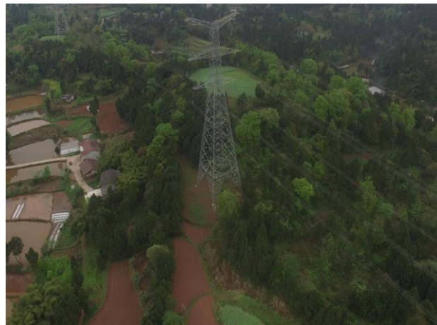
塔基面貌（四川段，2021.3）
