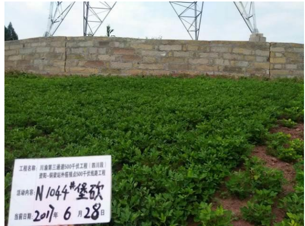
塔基挡墙面貌（四川段1标，2017.6）
