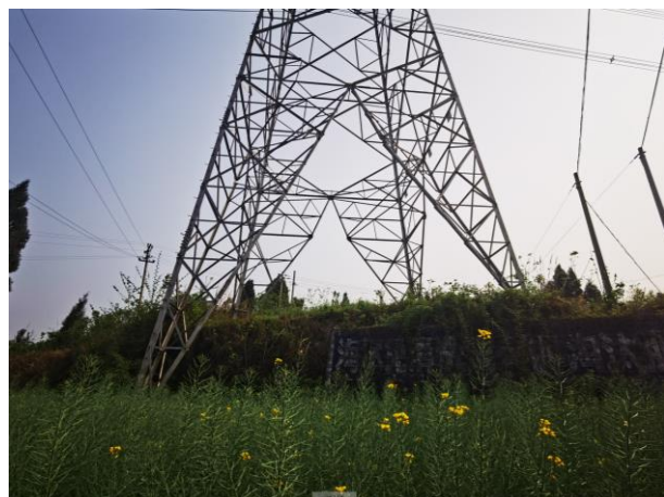
4#-3 监测点, 287 (N4039) 塔基, 2021.3
