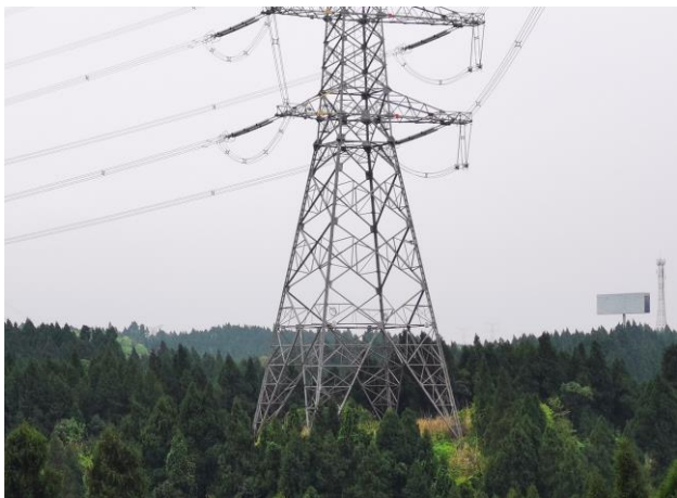
塔基面貌（四川段，2021.3）
