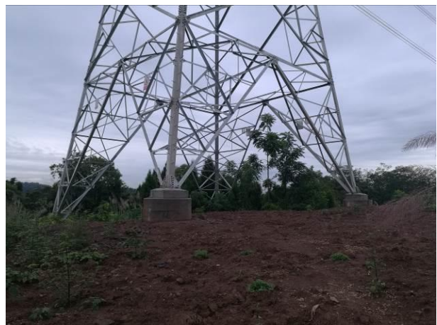
塔基面貌（四川段2标，2017.10）
