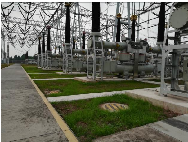
资阳变扩建区面貌（2017.12）
