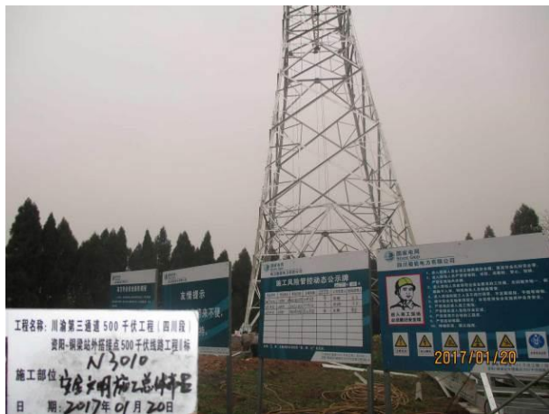
塔基施工面貌（四川段2标，2017.1）
