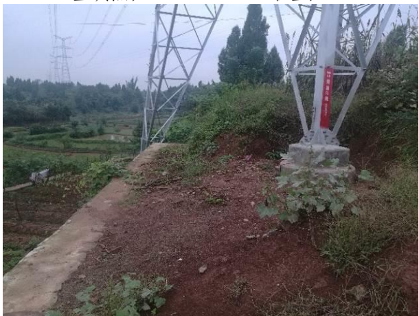
4#-3 监测点, 287 (N4039) 塔基, 2017.11
