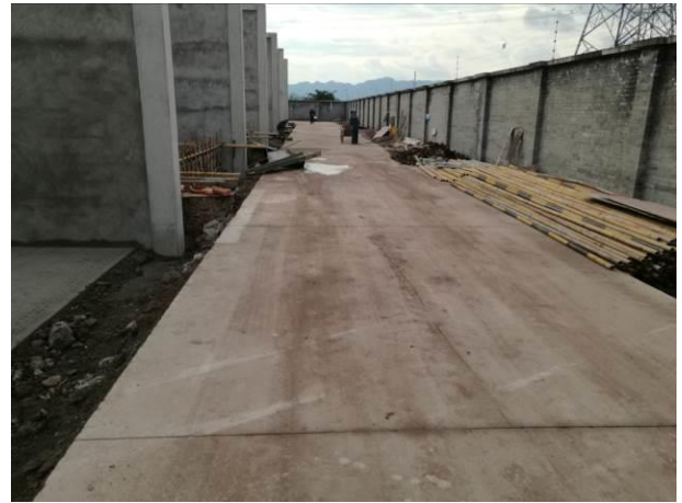
思源变扩建区施工面貌（2017.3）
