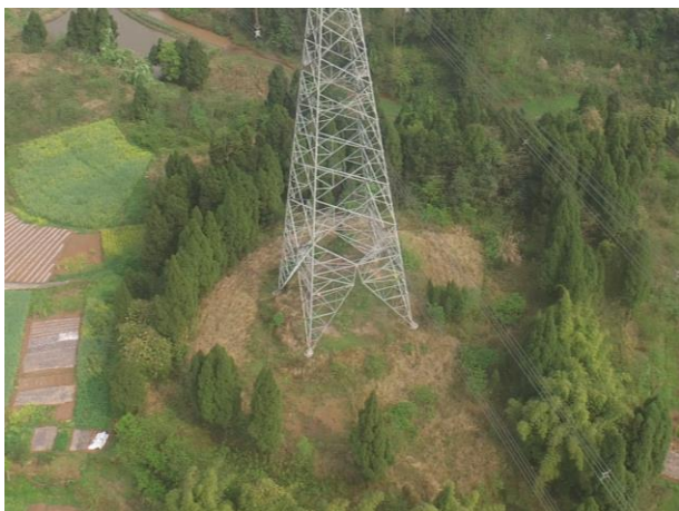
4#-1 监测点, 291 (N4043) 塔基, 2021.3
