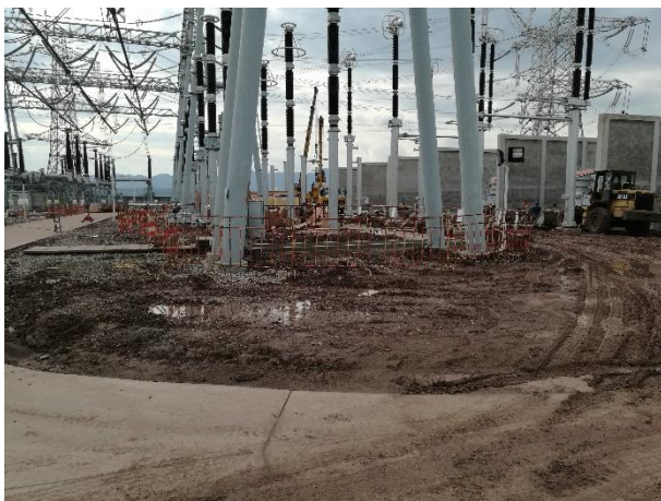
思源变扩建区碎石铺垫前（2017.3）
