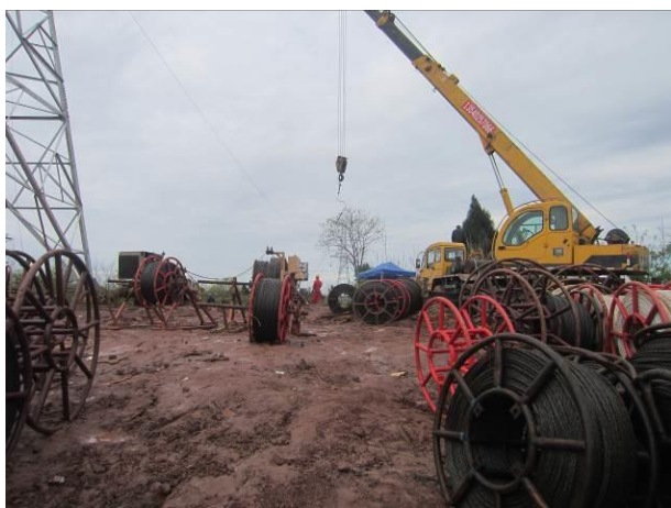
N3004牵张场施工面貌（2017.3）
