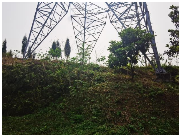
N4042塔基植被恢复（2021.3）
