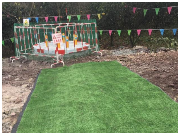
塔基施工占地临时覆盖 (2016.12)
