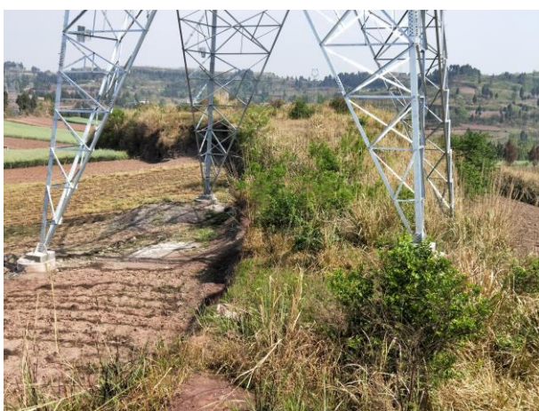
3#-2监测点, 040 (N1041) 塔基, 2018.4
