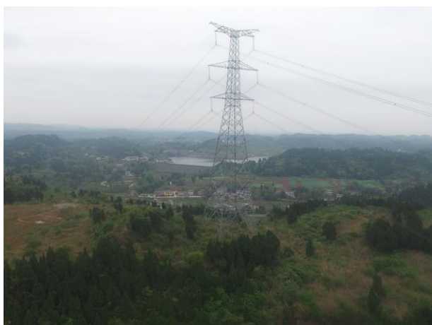
塔基面貌（四川段，2021.3）
