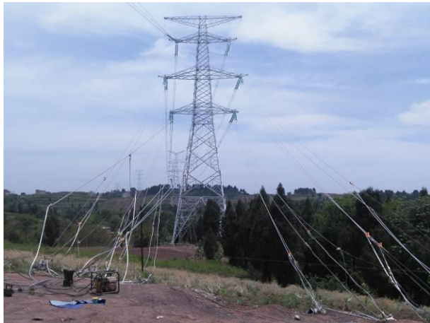
放线场及塔基施工面貌（四川段1标，2017.5）
