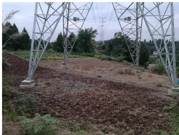
3#-2监测点, 040 (N1041) 塔基, 2017.9
