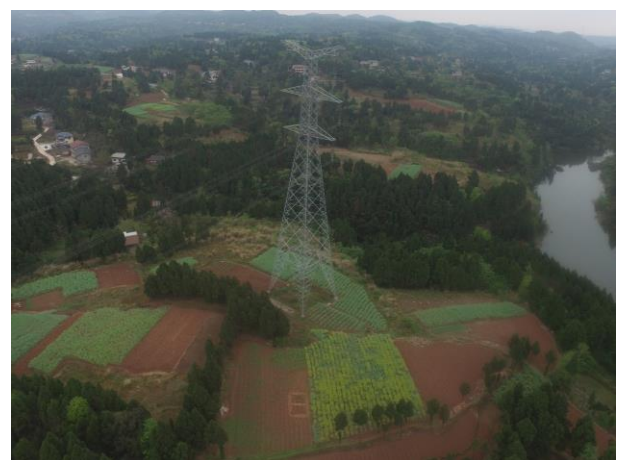
塔基面貌（四川段，2021.3）
