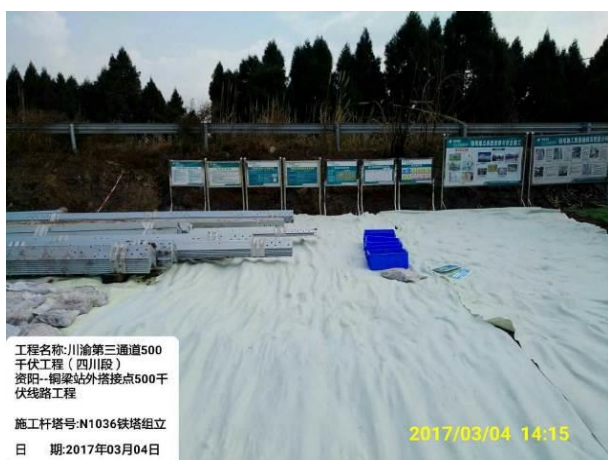
塔基施工占地临时覆盖 (2017.3)
