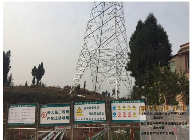
塔基施工面貌（重庆段，2017.1）
