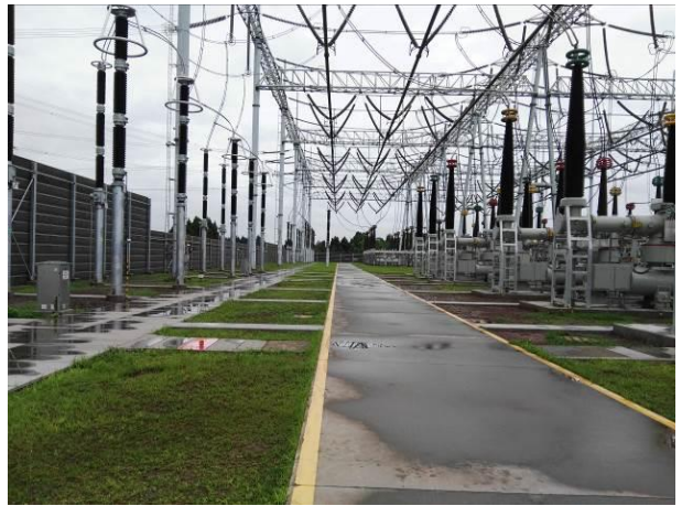
资阳变扩建区面貌（2017.7）
