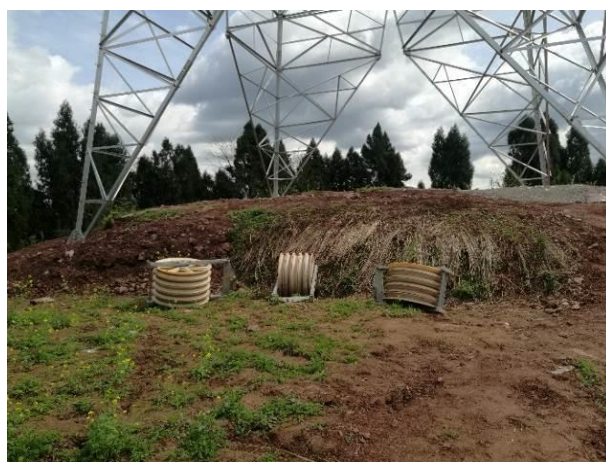
4#-1监测点, 291 (N4043) 塔基, 2017.3
