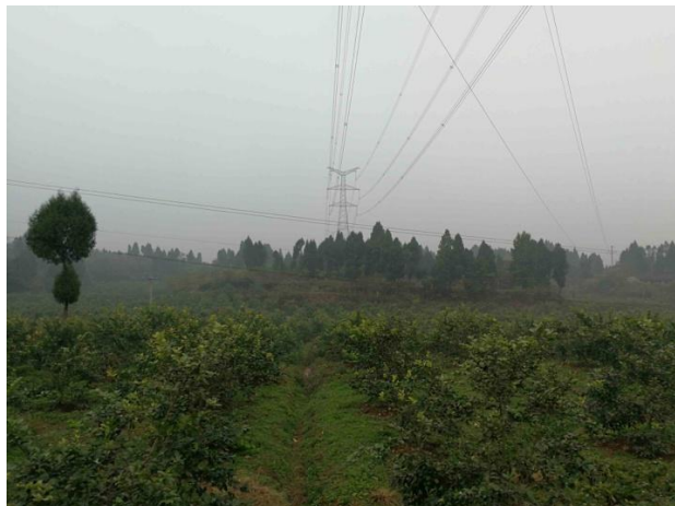
塔基及牵张场面貌（重庆段，2019.5）
