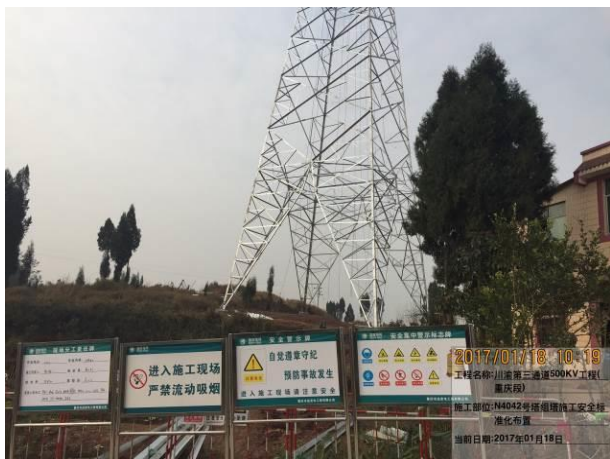
N4042塔基施工面貌（2017.1）
