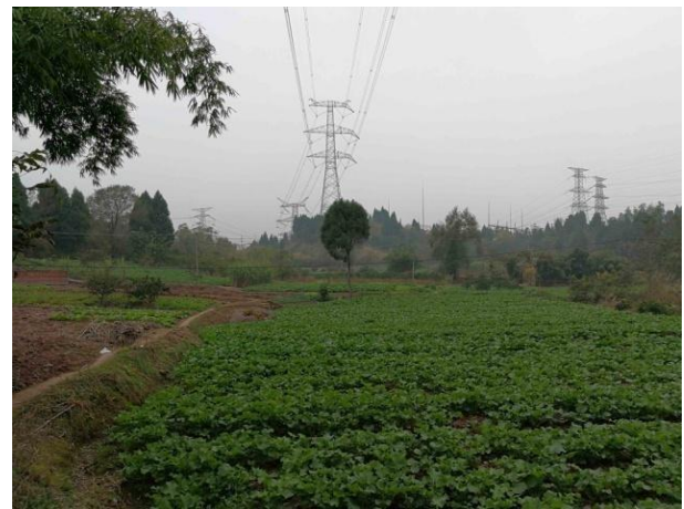
塔基及临时占地面貌（四川段1标，2019.2）
