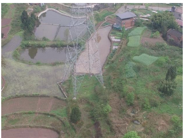
4#-2 监测点, 307 (N4059) 塔基, 2021.3
