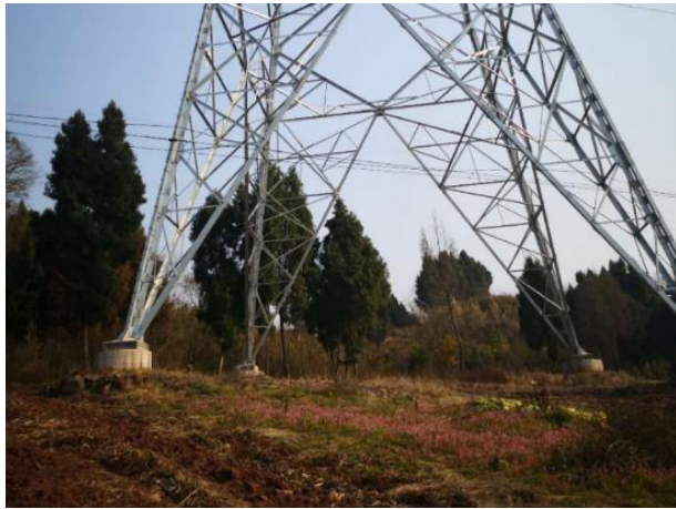
塔基面貌（四川段1标，2019.1）
