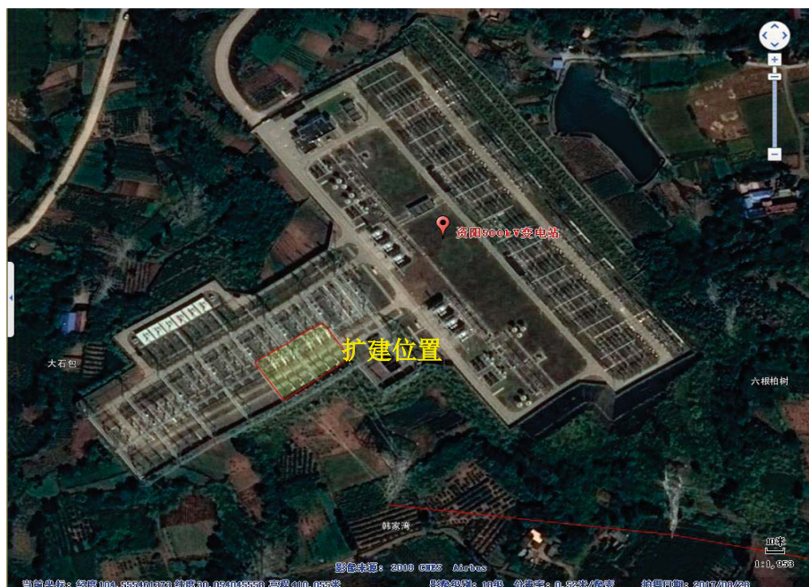
图 1-4 资阳 500kV 变电站扩建工程
