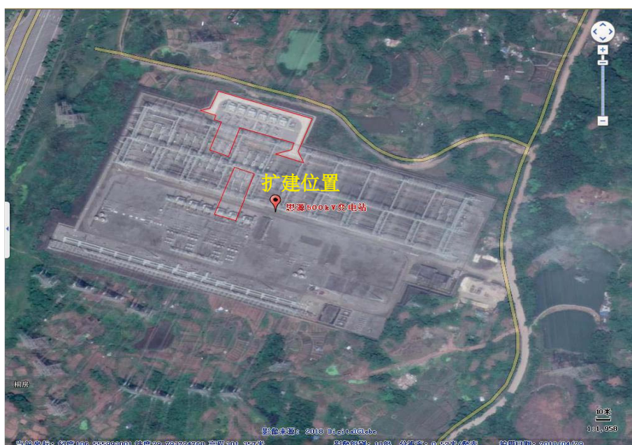
图 1-5 思源 500kV 变电站扩建工程
