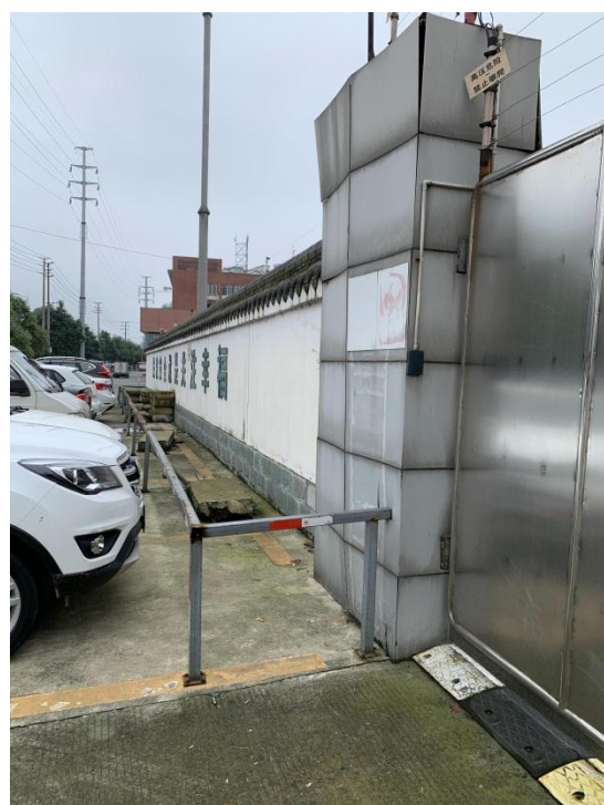
变电站站外情况
