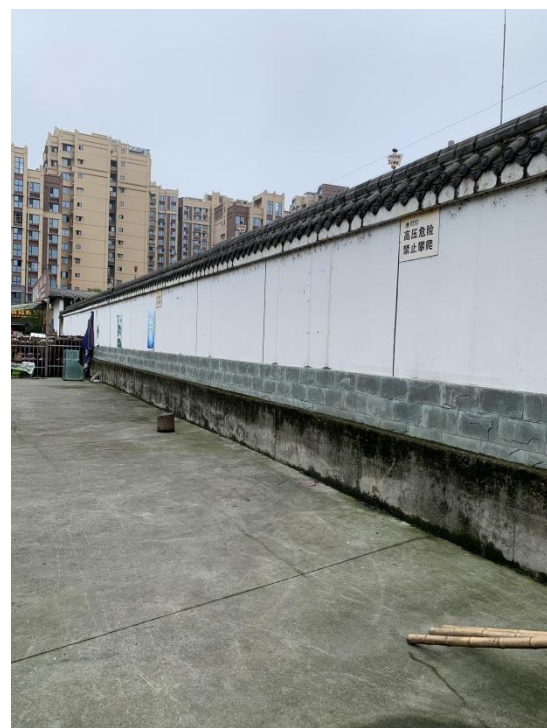
变电站挡土墙
