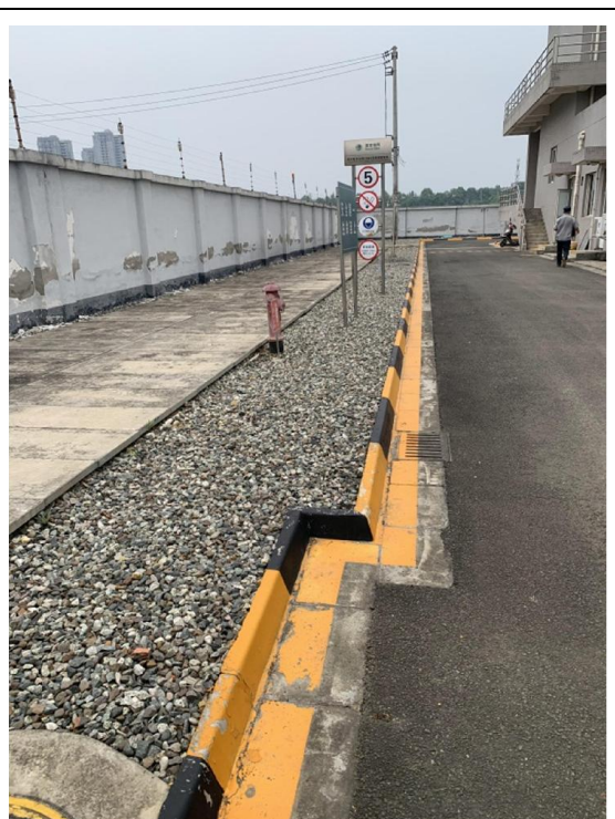
变电站内情况
