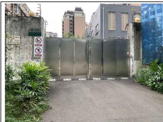
变电站大门外情况
