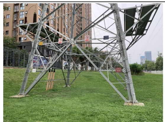
新建 N2 号塔
