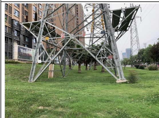
新建 N1 号塔
