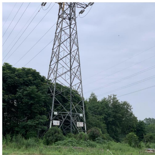
苏庄线 24 号塔植被恢复情况
