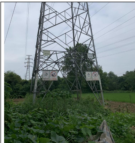
苏庄线 21 号塔耕地恢复情况
