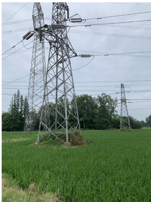
苏庄线 28 号塔耕地恢复情况
