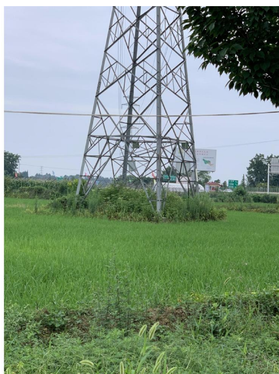
苏庄线 42 号塔耕地恢复情况
