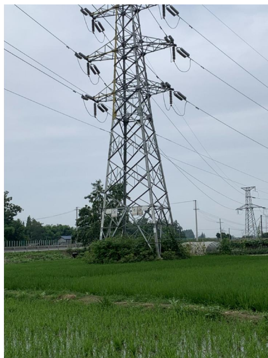
苏庄线 27 号塔耕地恢复情况
