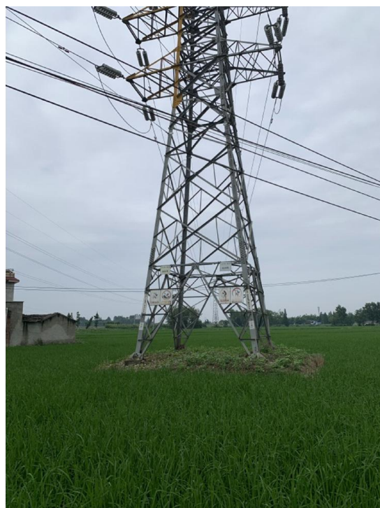
苏庄线 29 号塔耕地恢复情况
