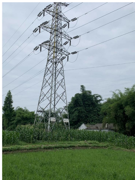
苏庄线 26 号塔耕地恢复情况
