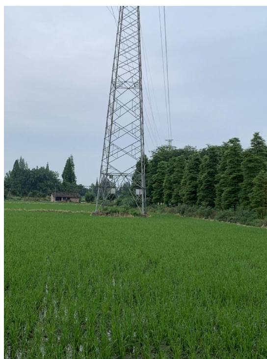
苏庄线 57 号塔耕地恢复情况
