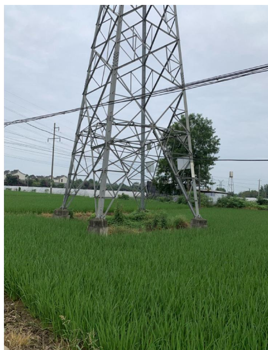
苏庄线 20 号塔耕地恢复情况
