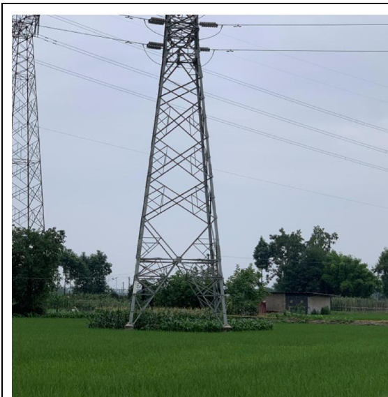
苏庄线 17 号塔耕地恢复情况
