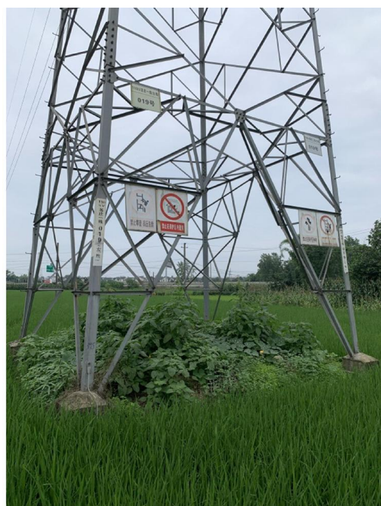
苏庄线 19 号塔耕地恢复情况
