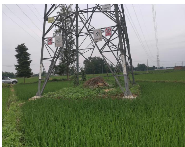
14#塔迹地恢复情况
