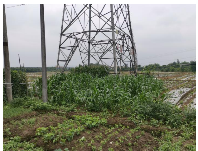
27#塔迹地恢复情况
