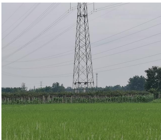
7#塔迹地恢复情况
