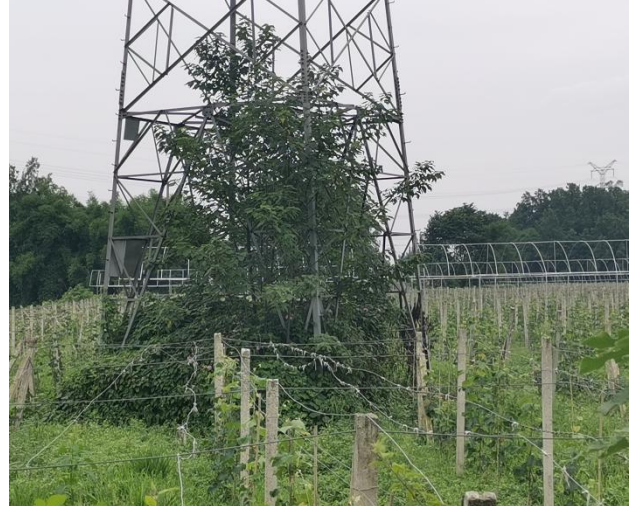
4#塔迹地恢复情况
