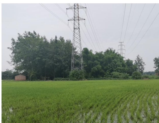
8#塔迹地恢复情况
