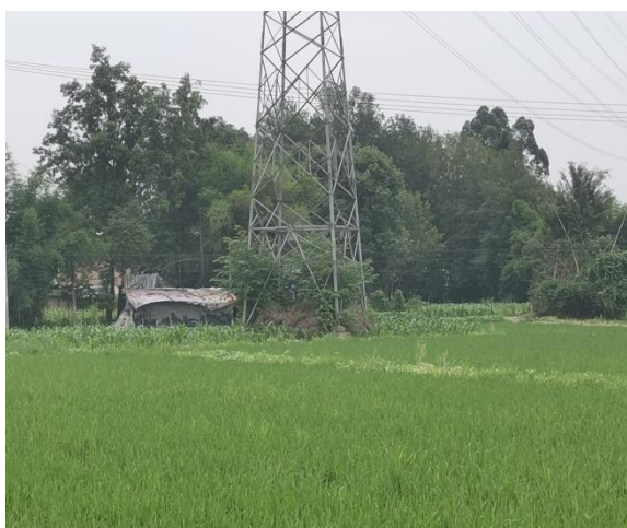
13#塔迹地恢复情况
