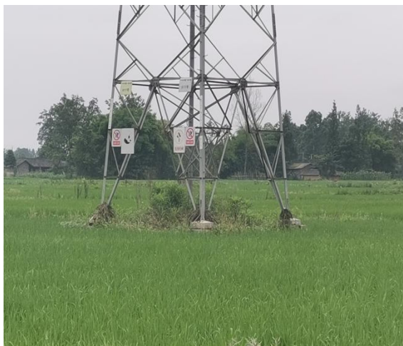
11#塔迹地恢复情况
