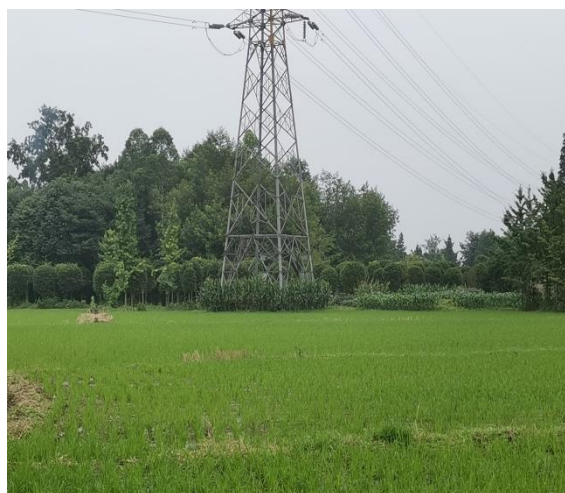
22#塔迹地恢复情况
