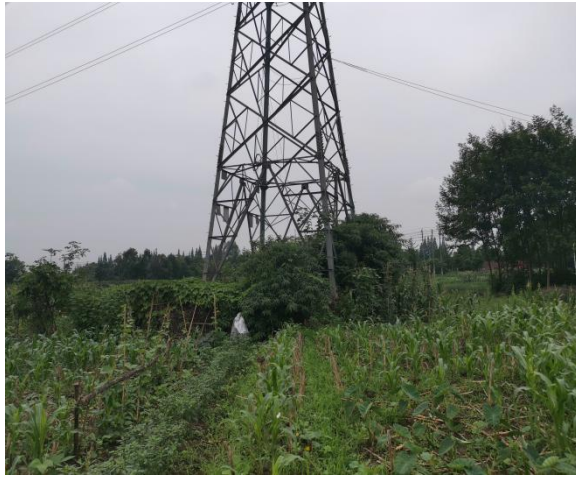
32#塔迹地恢复情况
