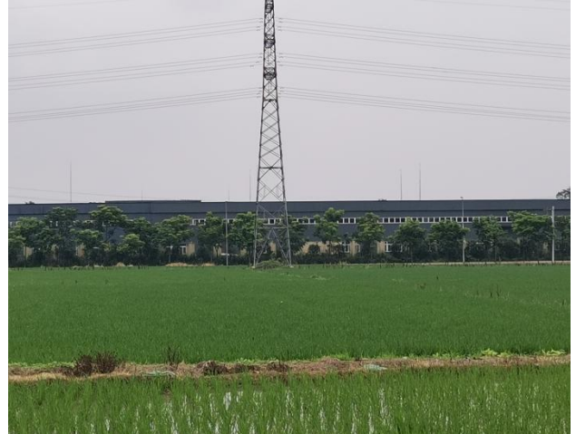
31#塔迹地恢复情况
