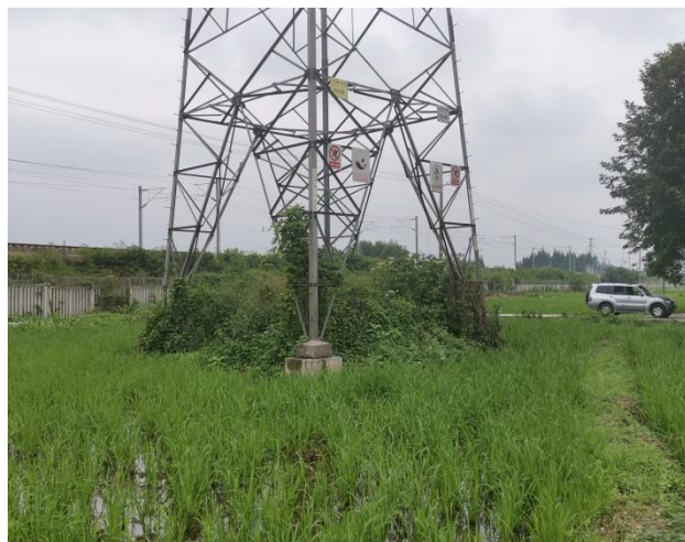
25#塔迹地恢复情况
