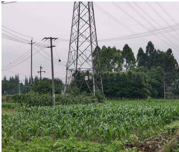
30#塔迹地恢复情况
