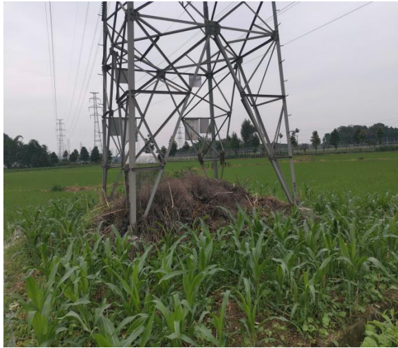
5#塔迹地恢复情况
