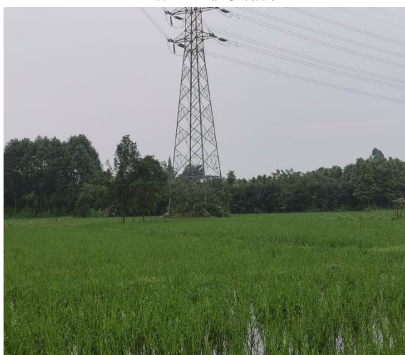
24#塔迹地恢复情况
