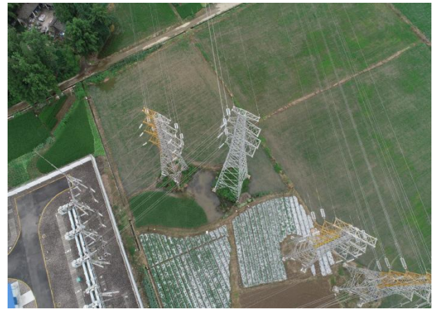
1#塔迹地恢复情况
