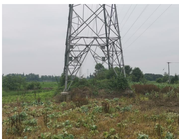
12#塔迹地恢复情况
