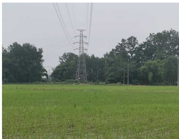
18#塔迹地恢复情况
