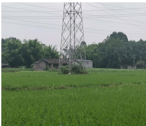
9#塔迹地恢复情况
