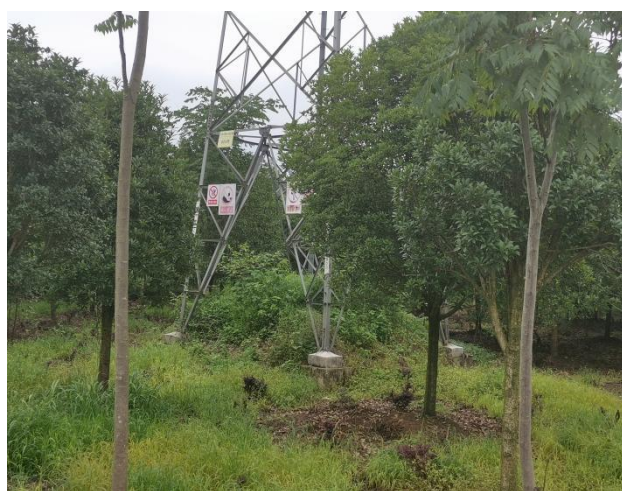
23#塔迹地恢复情况
