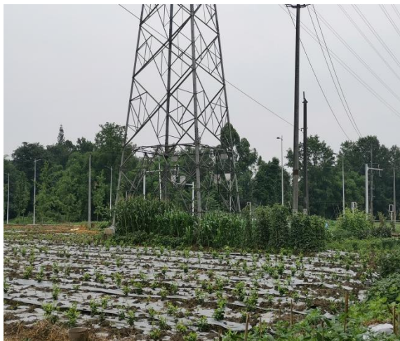
28#塔迹地恢复情况
