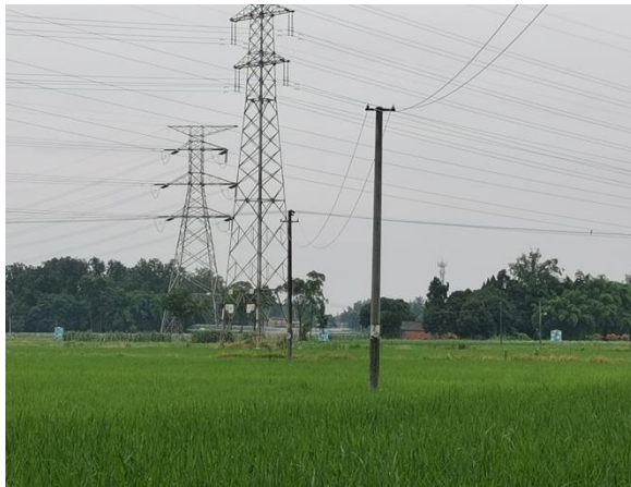
2#塔迹地恢复情况
