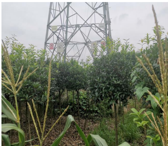
19#塔迹地恢复情况
