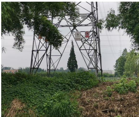
26#塔迹地恢复情况
