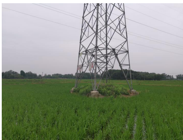
10#塔迹地恢复情况
