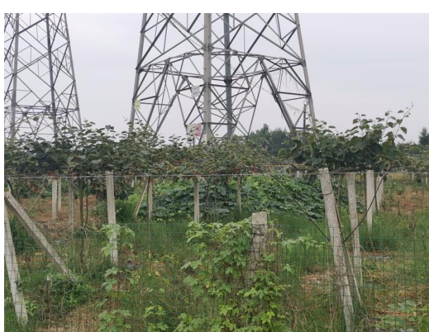
6#塔迹地恢复情况
