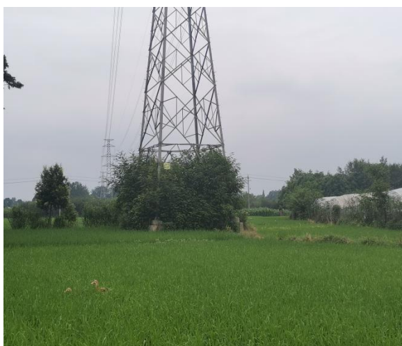
16#塔迹地恢复情况
