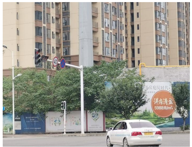
11#杆塔迹地恢复情况
