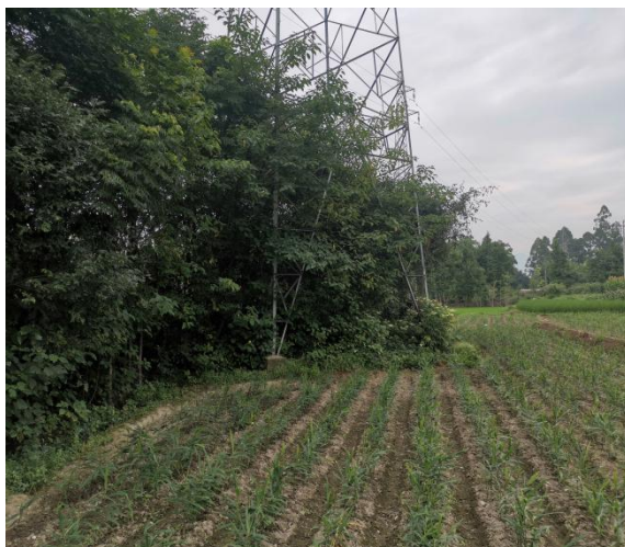
66#塔迹地恢复情况
