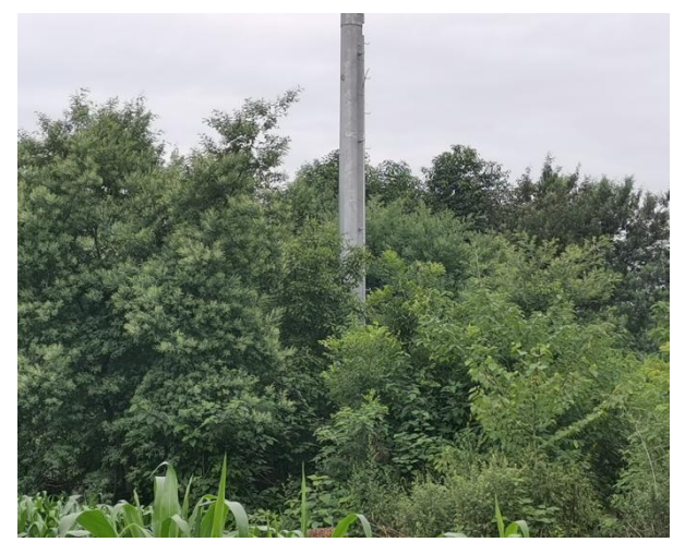
57#塔迹地恢复情况
