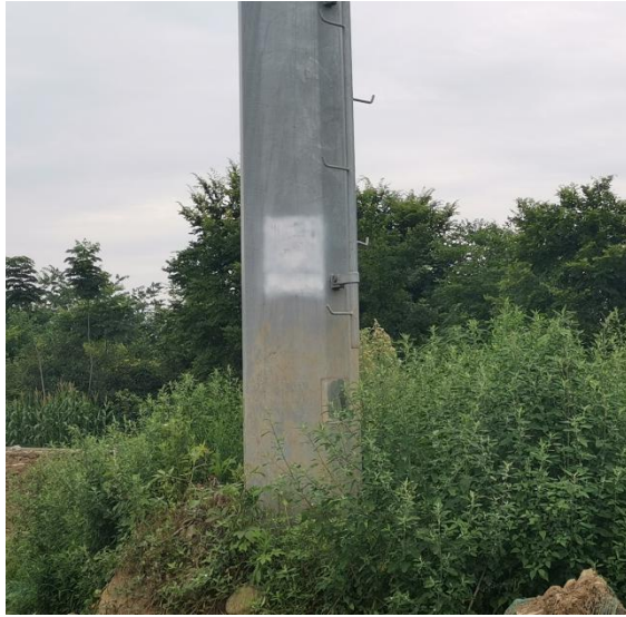
29#塔迹地恢复情况
