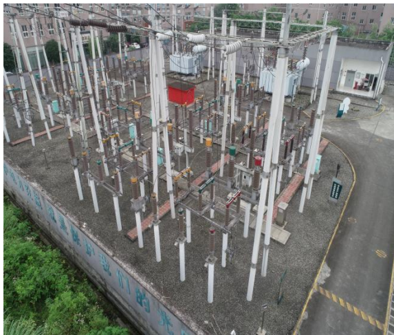
万家变间隔扩建现状
