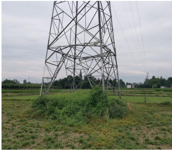
58#塔迹地恢复情况
