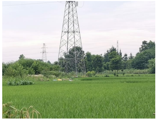
59#塔迹地恢复情况
