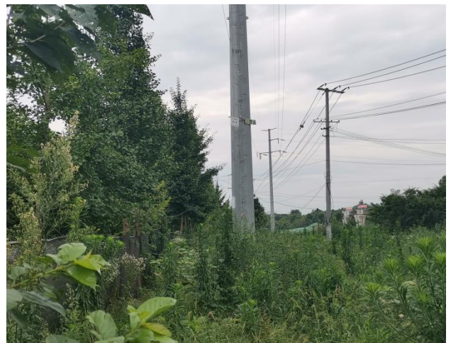
27#塔迹地恢复情况
