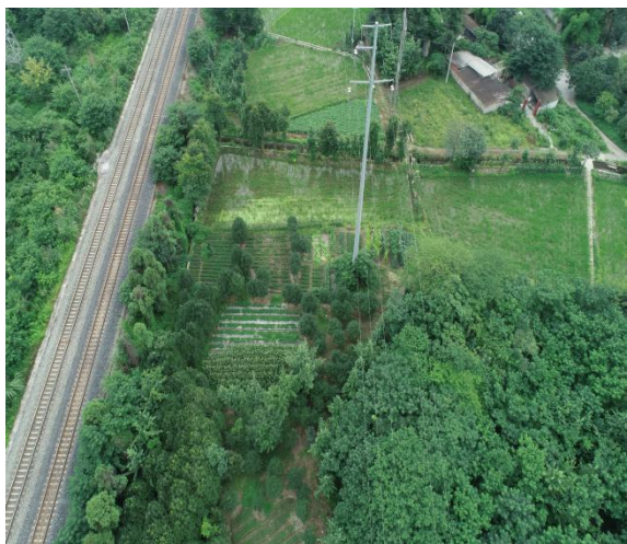
50#塔迹地恢复情况
