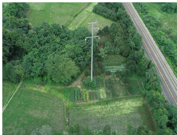
49#塔迹地恢复情况
