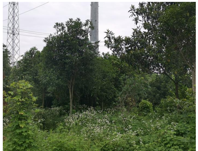
79#塔迹地恢复情况
