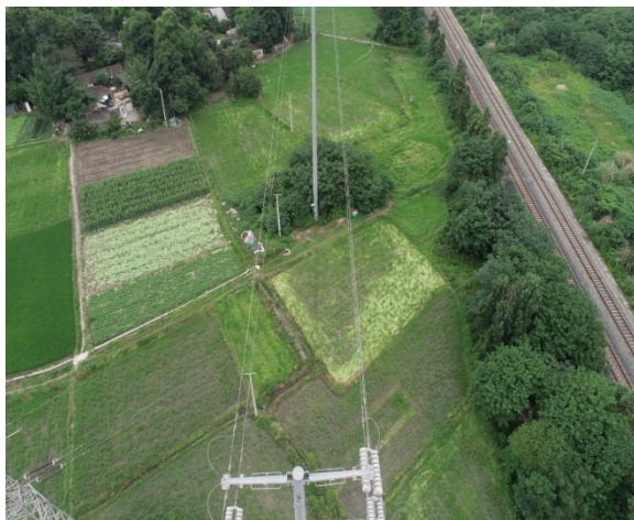
48#塔迹地恢复情况
