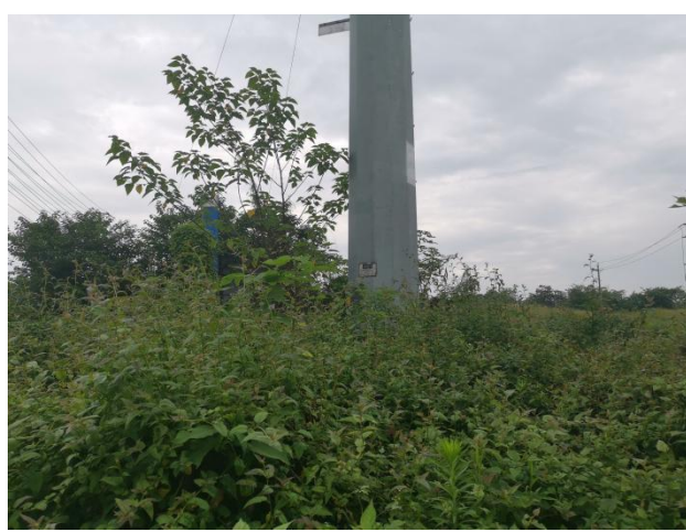
3#杆塔迹地恢复情况
