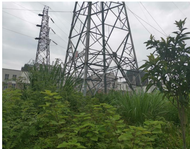
1#塔迹地恢复情况
