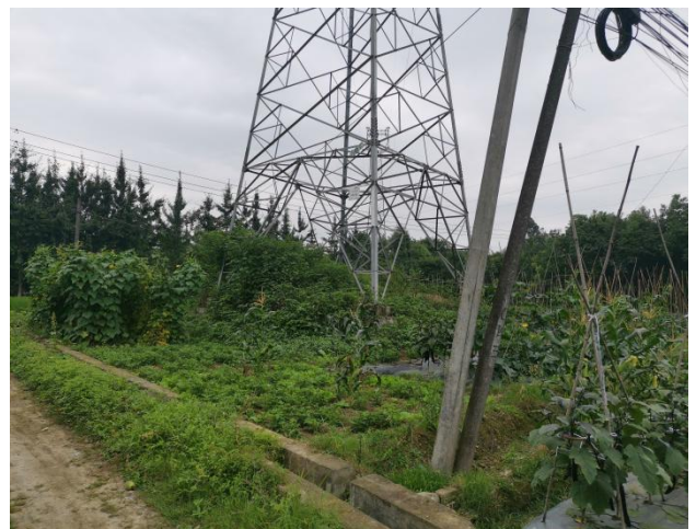
65#塔迹地恢复情况
