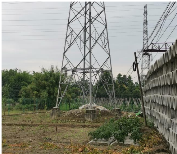
60#塔迹地恢复情况
