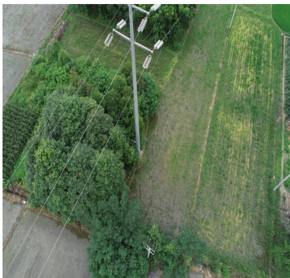
46#塔迹地恢复情况
