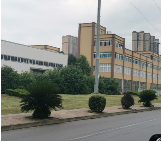
8#杆塔迹地恢复情况
