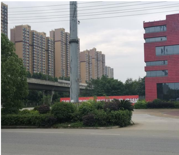
19#塔迹地恢复情况
