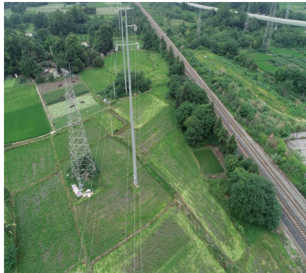
47#塔迹地恢复情况
