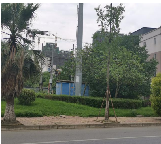
4#杆塔迹地恢复情况
