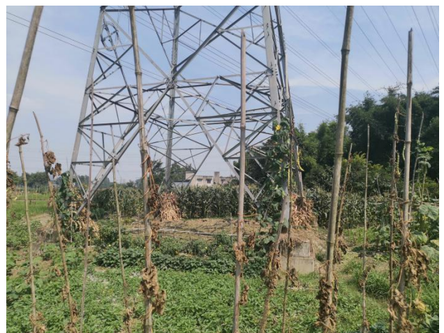
19#塔迹地恢复情况
