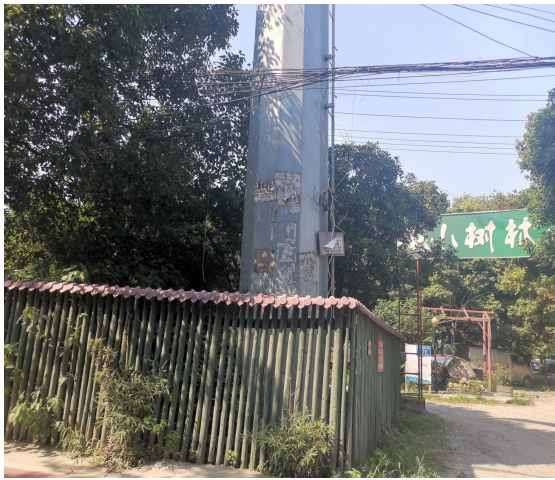
10#塔迹地恢复情况
