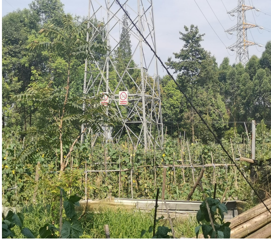
12#塔迹地恢复情况
