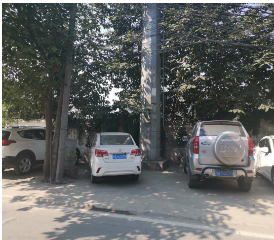
7#塔迹地恢复情况
