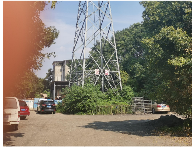
4#塔迹地恢复情况
