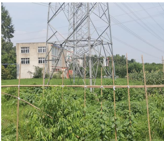
21#塔迹地恢复情况
