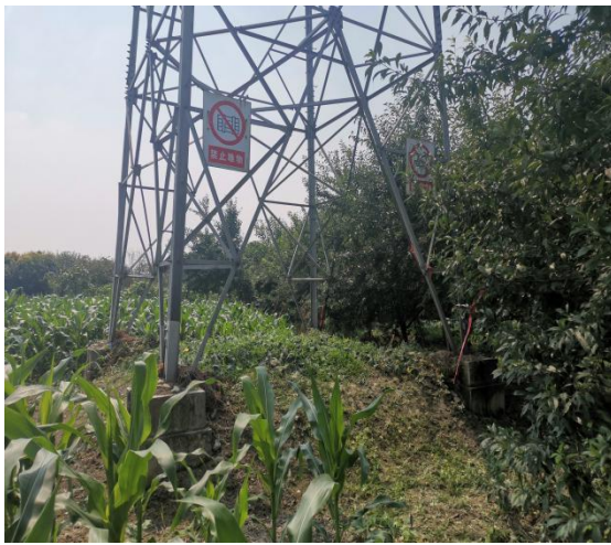
24#塔迹地恢复情况
