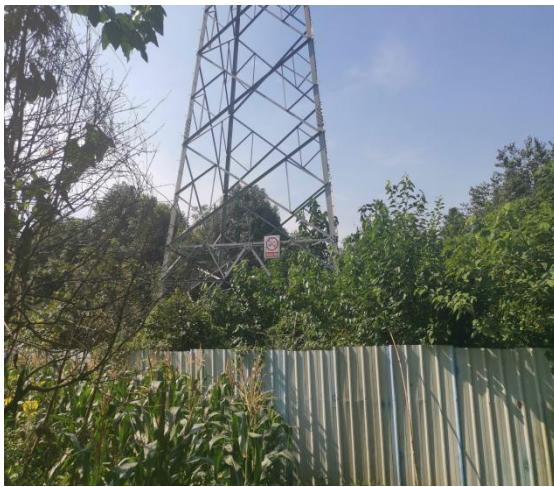
2#塔迹地恢复情况
