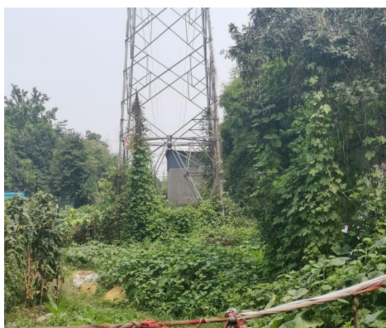
32#塔迹地恢复情况
