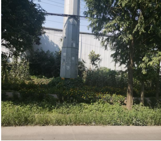
5#塔迹地恢复情况
