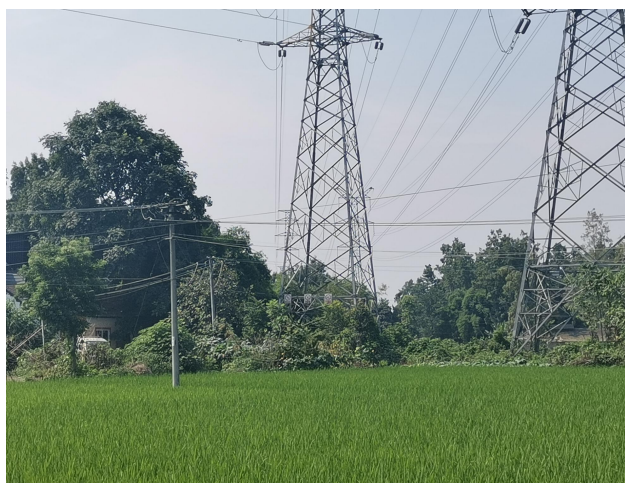
17#塔迹地恢复情况
