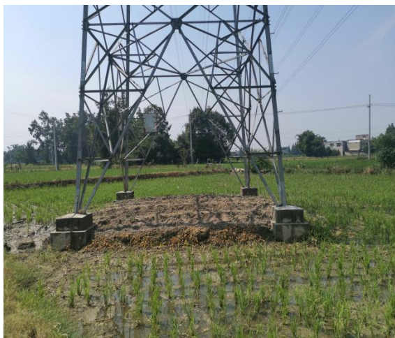
18#塔迹地恢复情况
