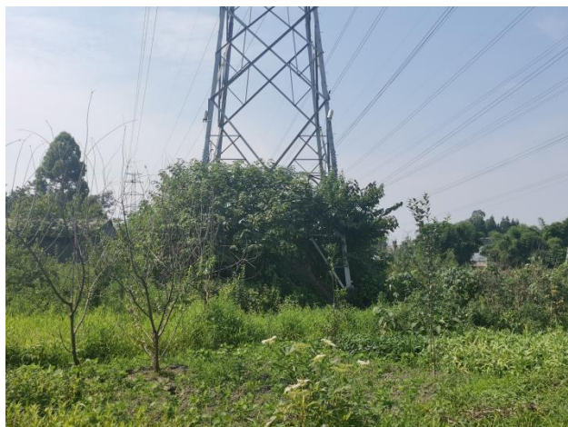
13#塔迹地恢复情况
