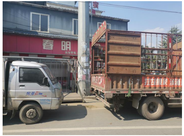
8#塔迹地恢复情况
