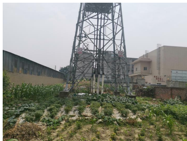
33#塔迹地恢复情况
