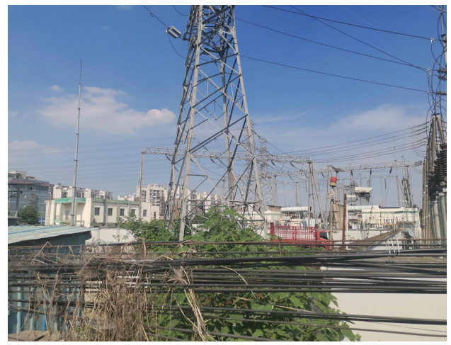
1#塔迹地恢复情况
