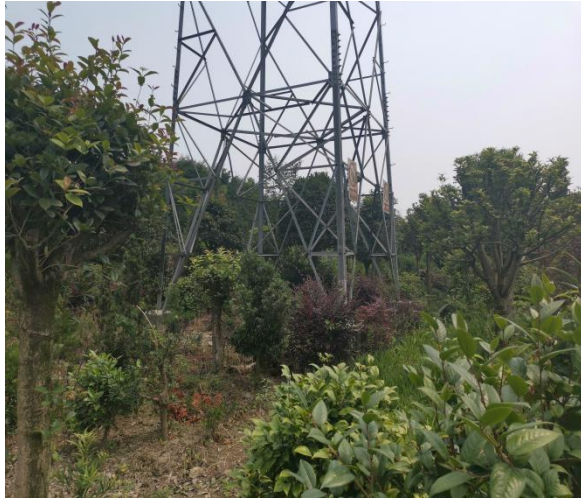
28#塔迹地恢复情况
