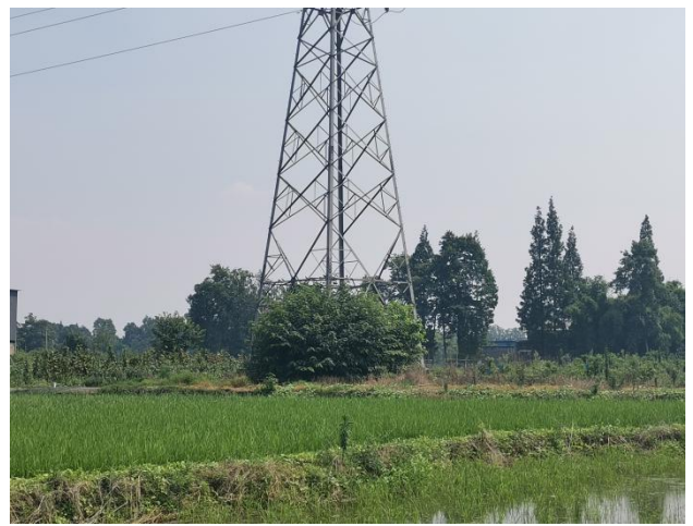
23#塔迹地恢复情况
