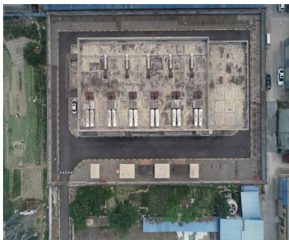
变电站布置、站外绿化情况
