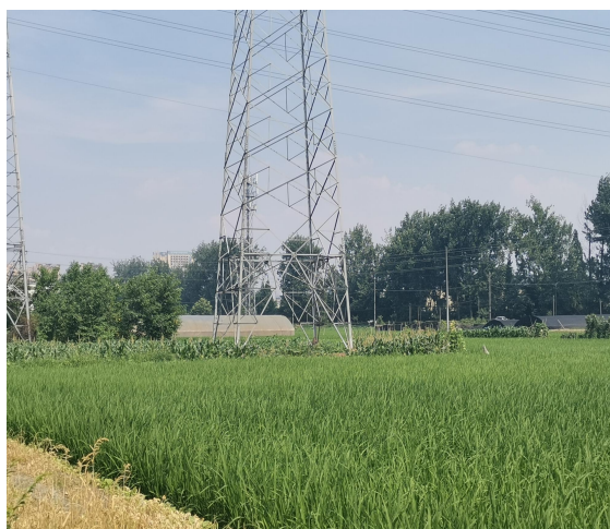
16#塔迹地恢复情况
