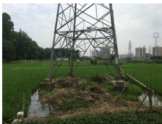
N14 号塔现状
