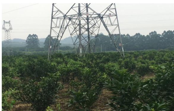
N3 号塔现状
