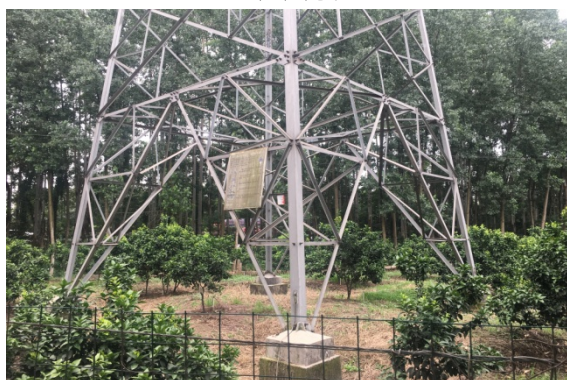
N5 号塔现状
