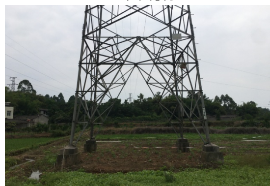
N7 号塔现状
