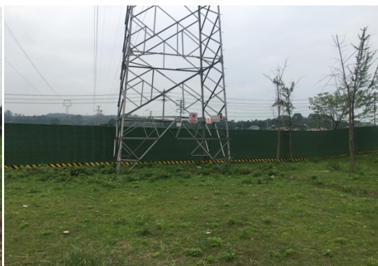
新建 N2 号塔现状
