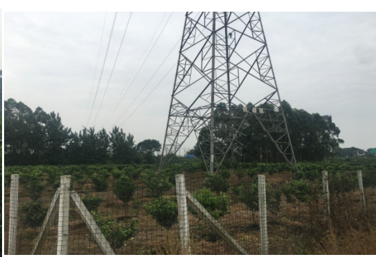
N4 号塔现状
