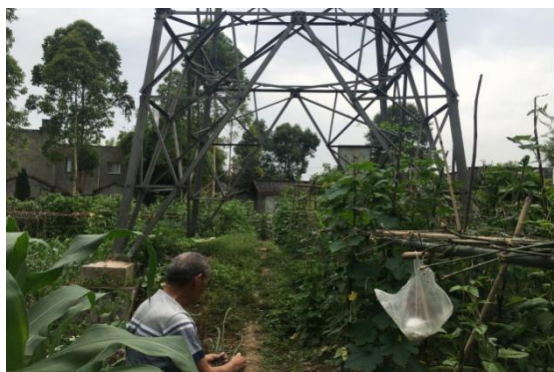
N11 号塔现状
