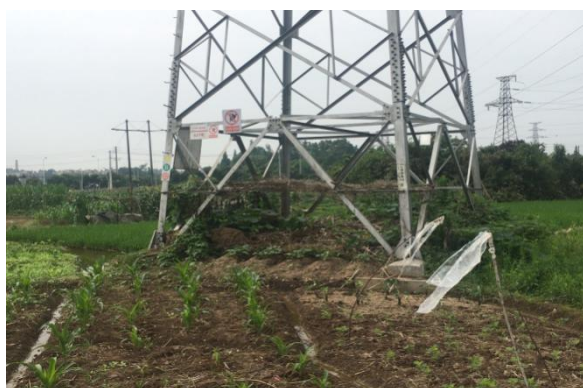
新建 N1 号塔现状
