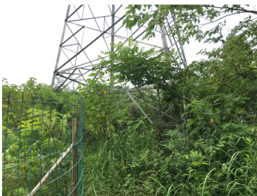
N9 号塔现状
