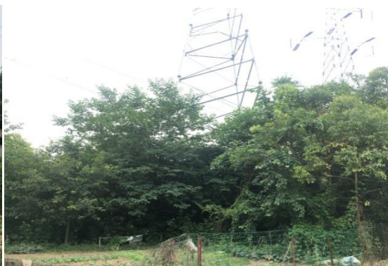
新建 N4 号塔现状
