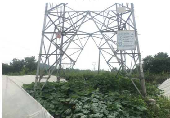
N6 号塔现状
