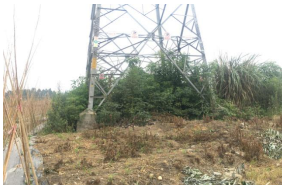
N1 号塔现状
