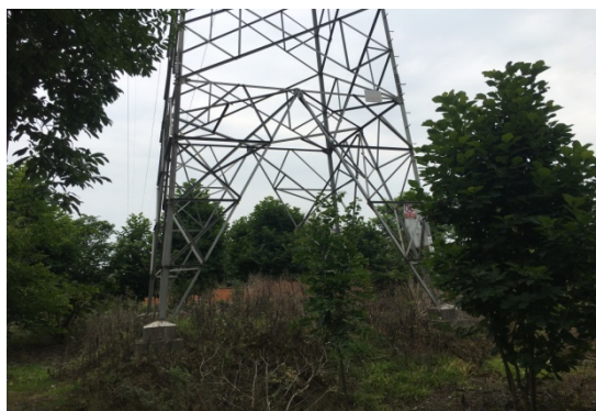
N10 号塔现状
