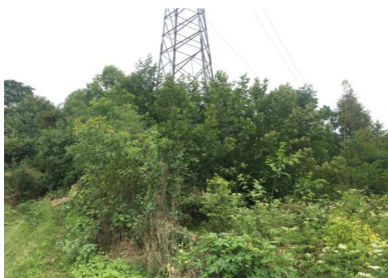
N13 号塔现状
