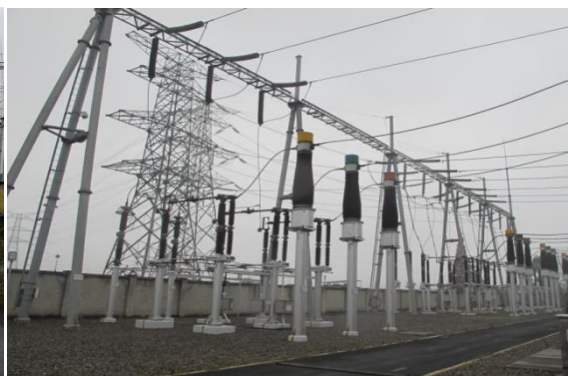
徐家渡变电站间隔扩建场地
