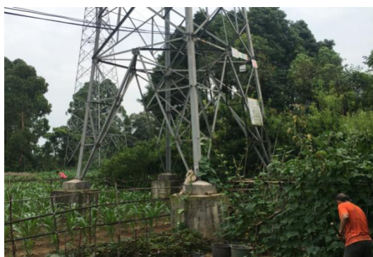
N12 号塔现状
