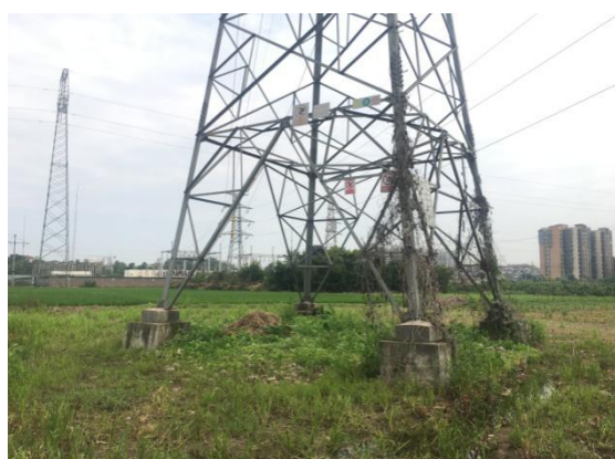
N15 号塔现状
