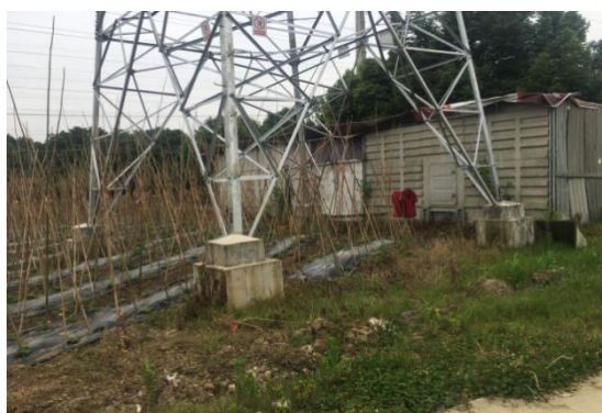
N2 号塔现状
