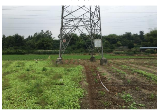
N8 号塔现状
