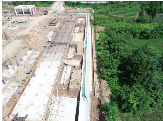
变电站站外排水沟
