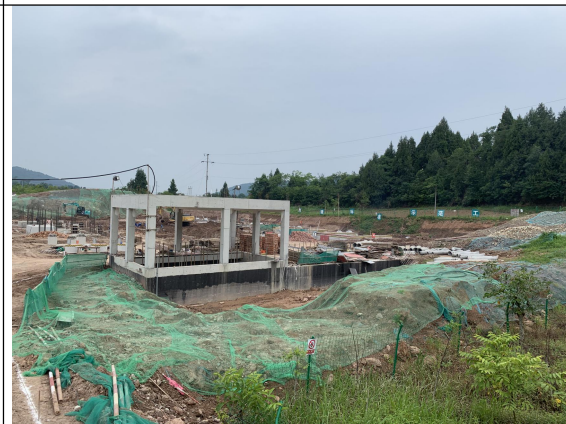
变电站密目网遮盖后
