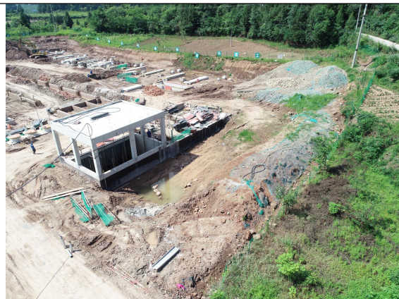
变电站密目网遮盖前
