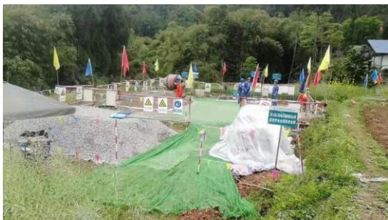
材料临时堆放区
