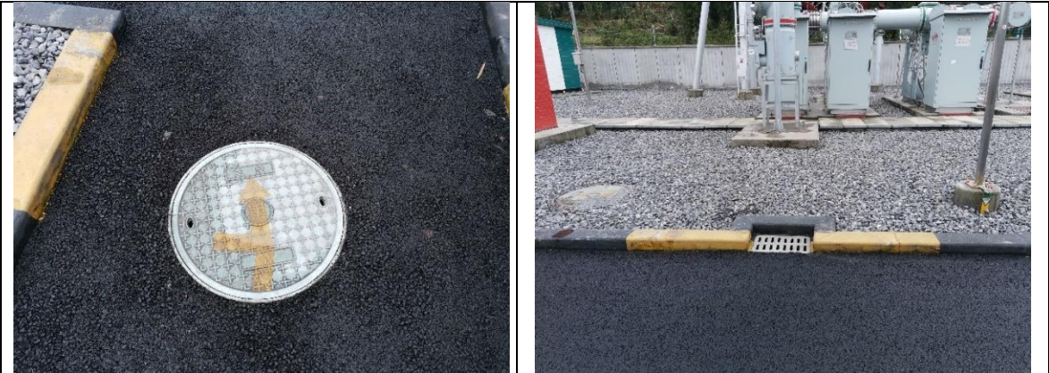
严桥 110kV 变电站站内排水工程
