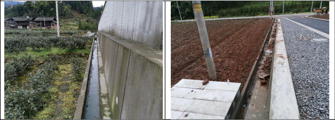
严桥 110kV 变电站站外排水沟及碎石覆盖
