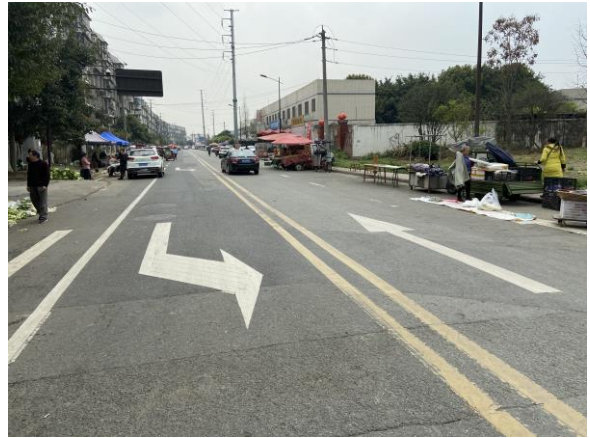
电缆铺设于道路下
