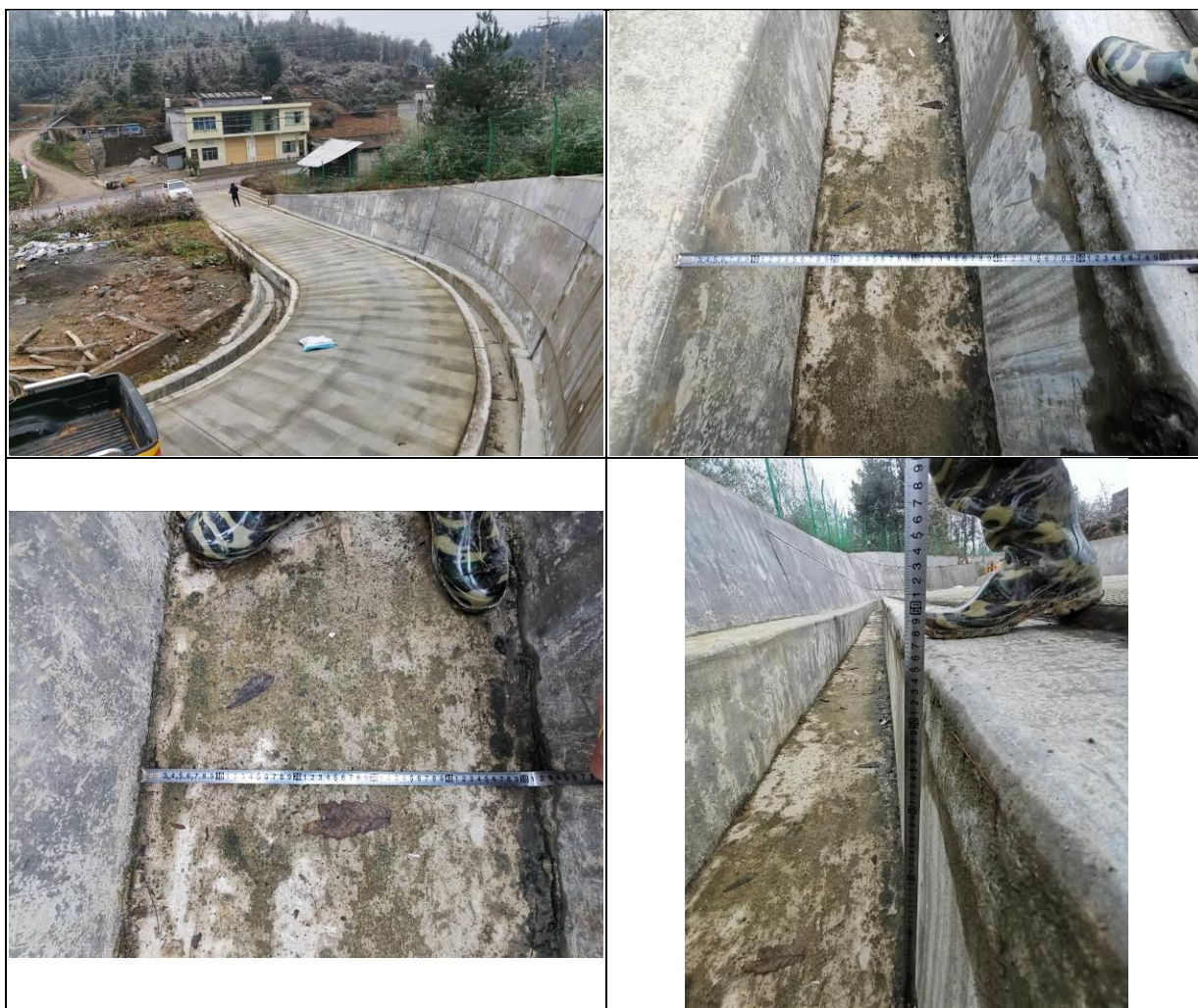
进站道路排水沟实地量测（2020年12月）
