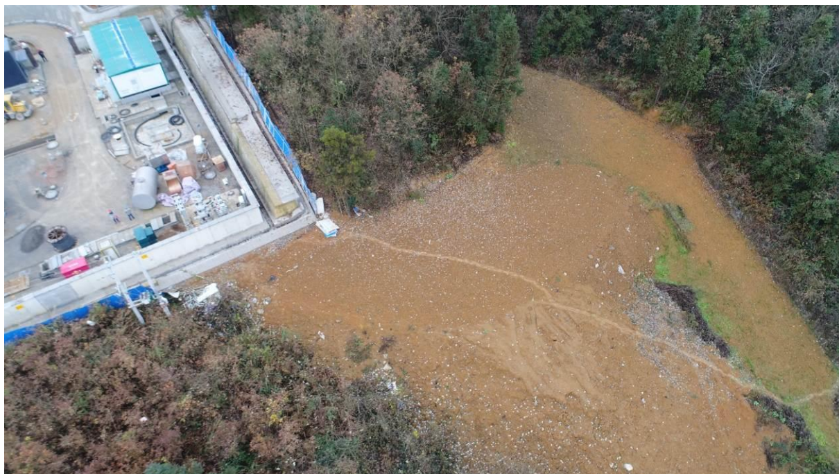
变电站北侧回填区域（施工期 2019 年 12 月）
