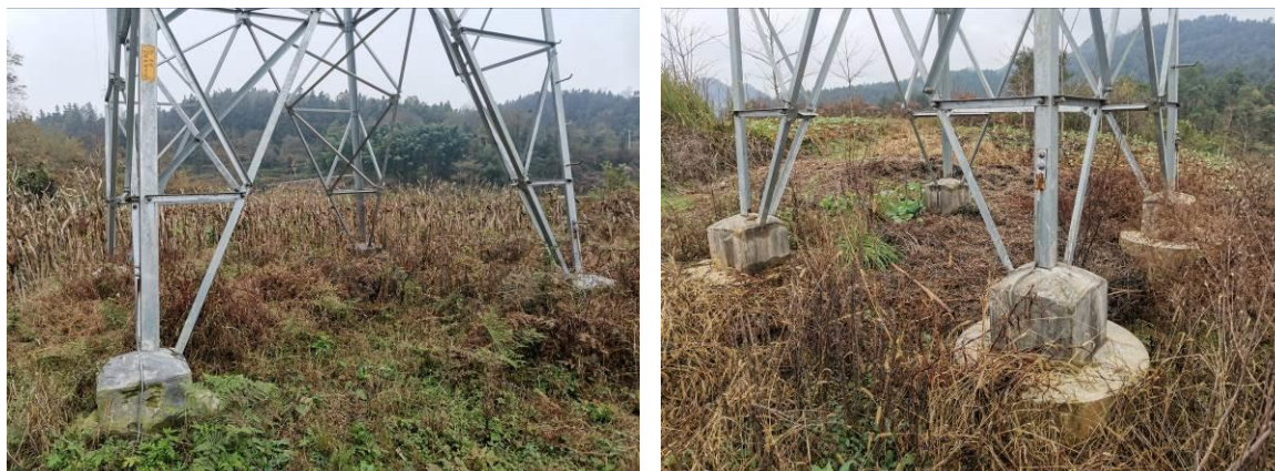
平铺弃土的塔基（2020 年 12 月）
