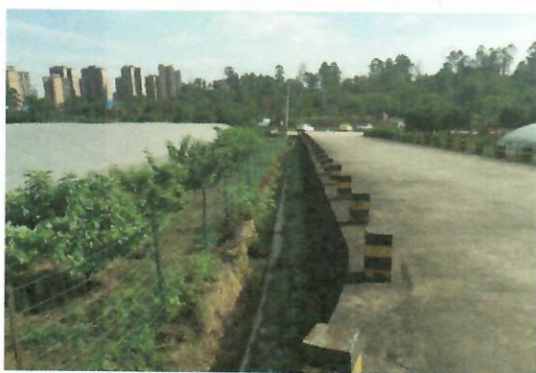
进站道路防护及排水沟
