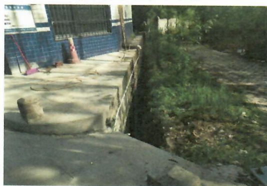
站内硬化及排水沟
