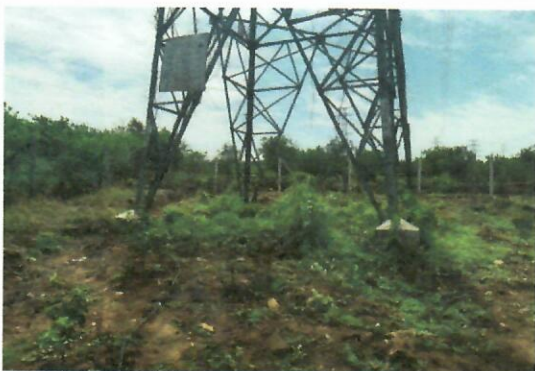
塔基覆土及植物绿化
