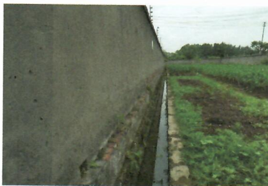
站外围墙排水沟
