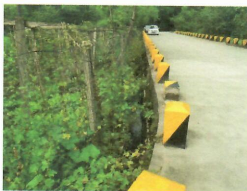
沿线道路排水沟
