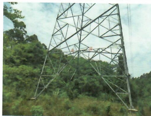
塔基底部加固及植草绿化 3
