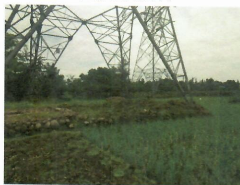
塔基底部加固及植草绿化 1
