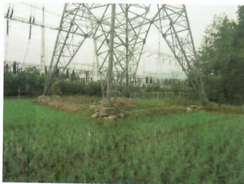
塔基底部加固及植草绿化 2
