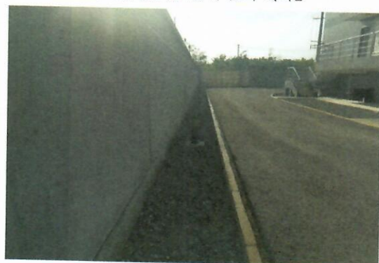
站内碎石压盖场地
