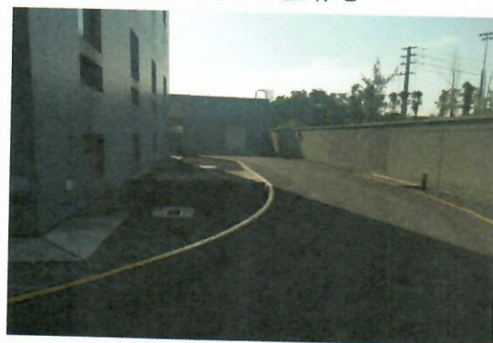
站内碎石压盖场地及雨水口 2
