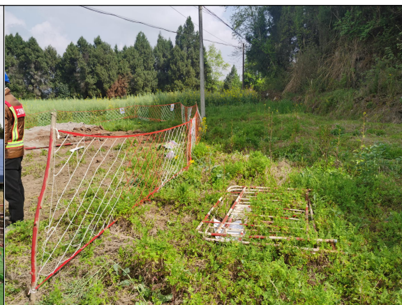
线路-塔基施工临时
