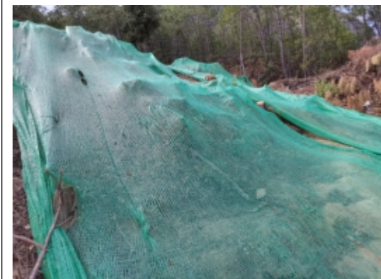
塔基施工表土剥离堆放
