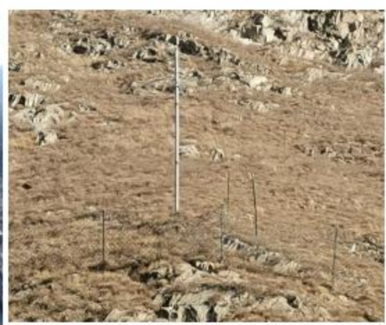
19 号单杆植被恢复情况
