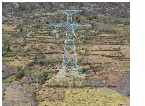
N0531 塔基区土地整治
