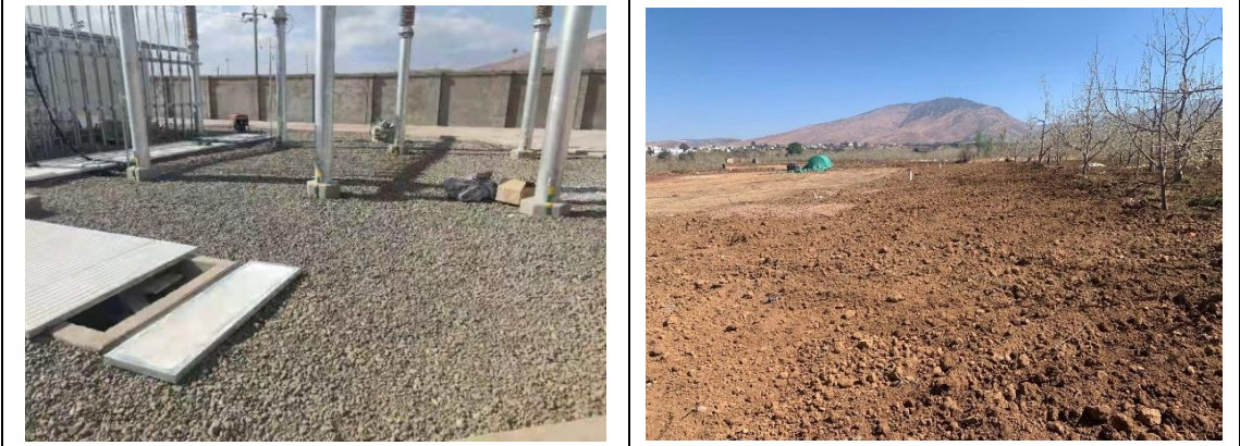
汇流装置区碎石铺设
