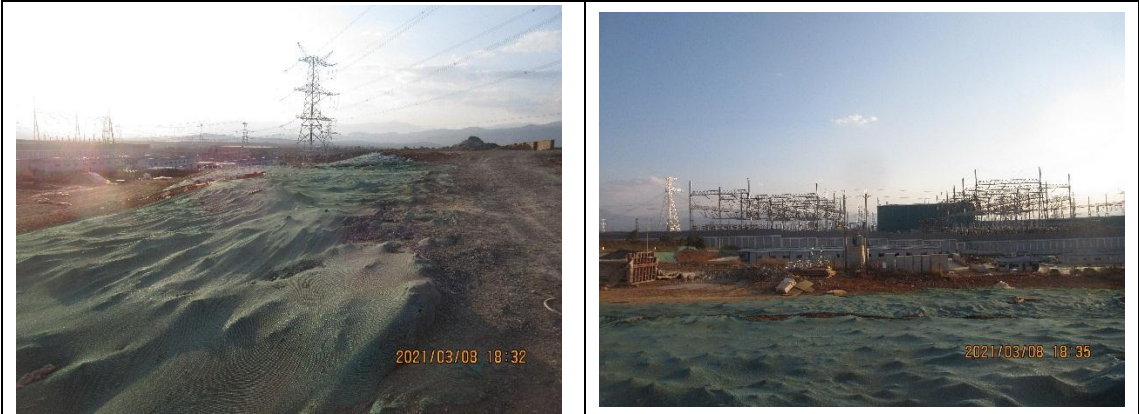
站外临时堆土区防尘网苫盖
