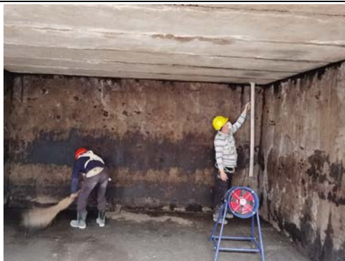
图 3 事故油池检修图
