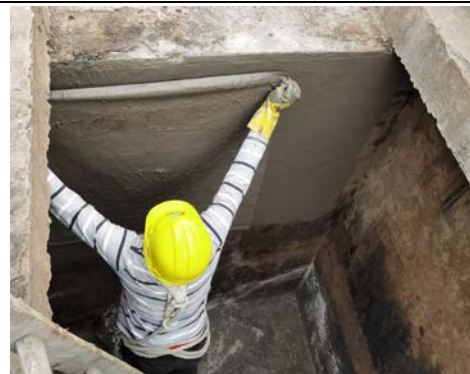
图 4 事故油池检修图
