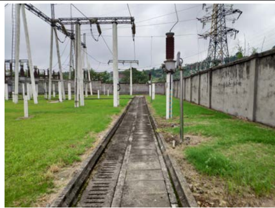
图 2 站内既有电缆沟
