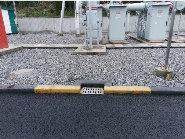
严桥 110kV 变电站站内排水及碎石覆盖
