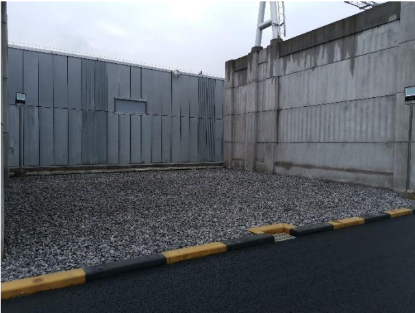
严桥 110kV 变电站站内排水及碎石覆盖
