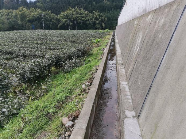
严桥 110kV 变电站站外排水及碎石覆盖
