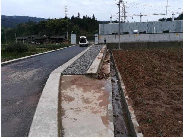
严桥 110kV 变电站站外排水及碎石覆盖
