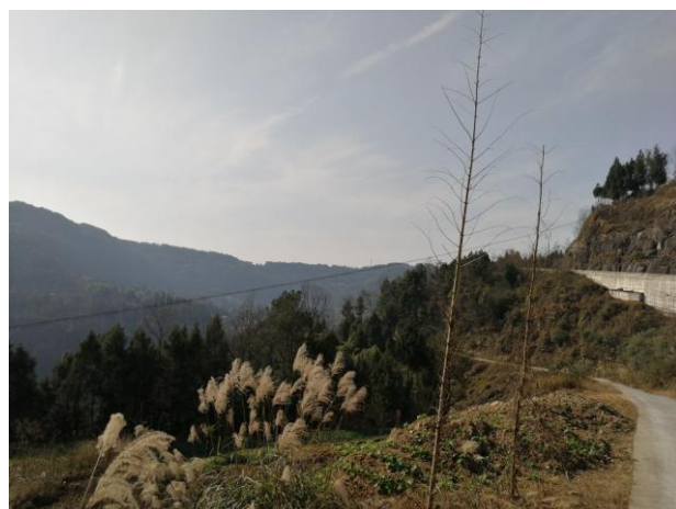
玉茶线龙显洞附近跨县道、跨山沟沿线情况
