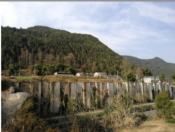
玉顶线跨高速沿线情况（玉山站方向）
