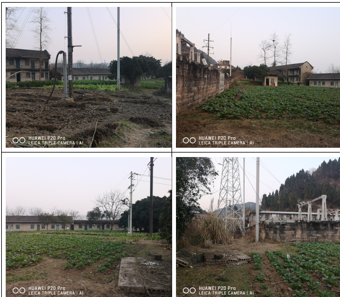
玉台 35kV 变电站站址区域
