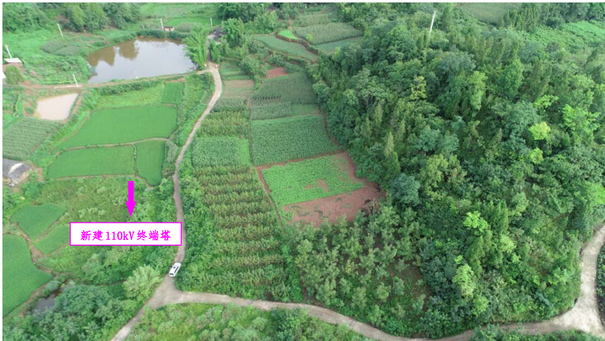
线路终端塔位置
