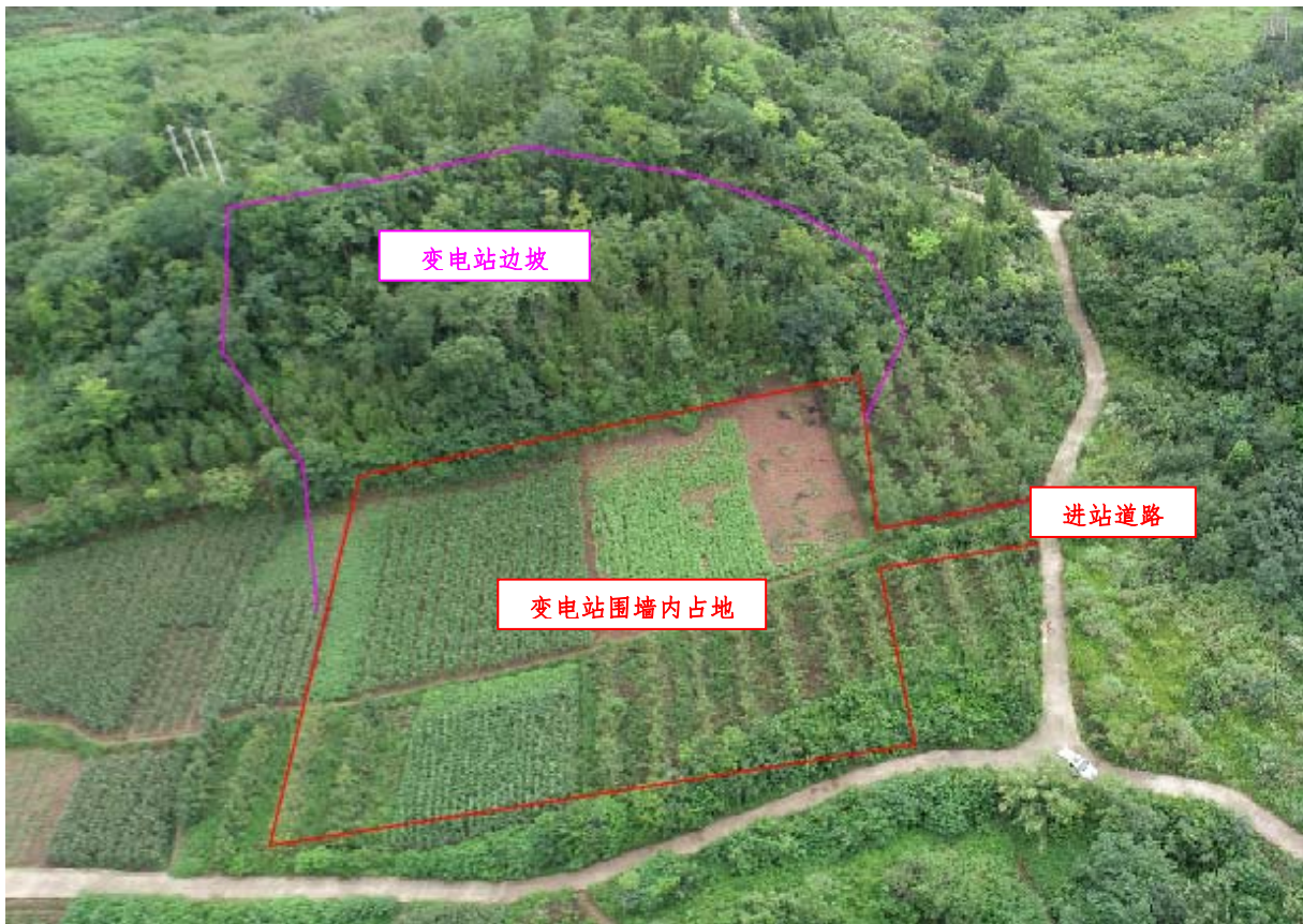
城西 110kV 变电站位置
