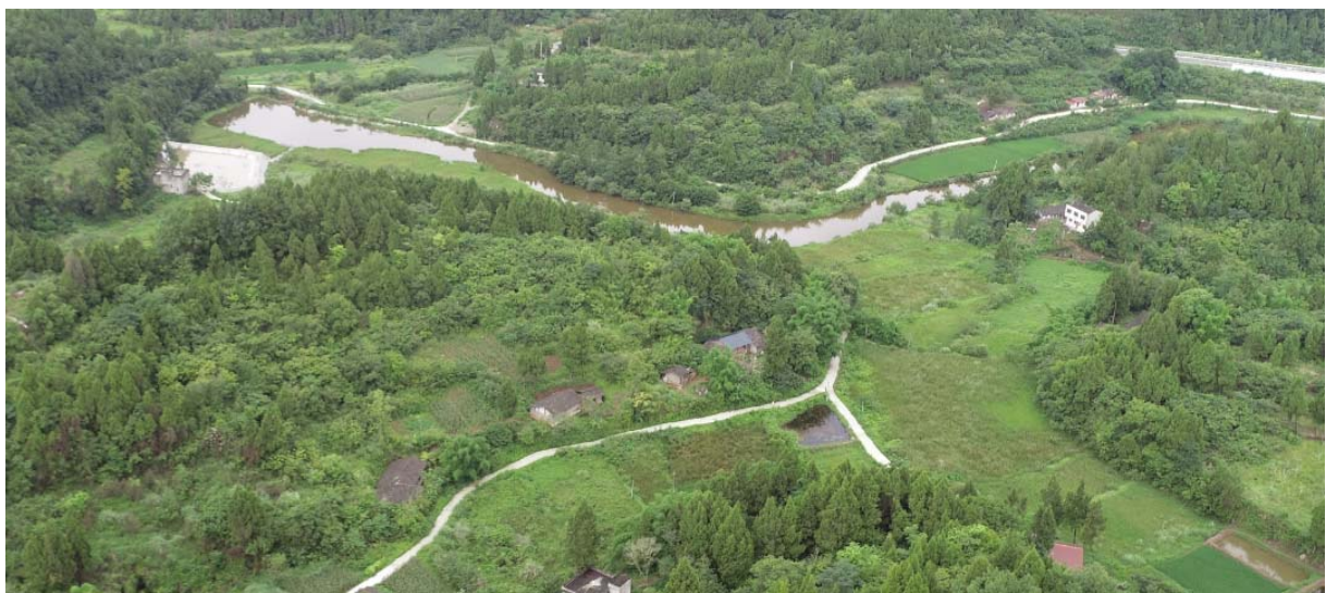
线路“ \pi ”接出线段地形地貌
