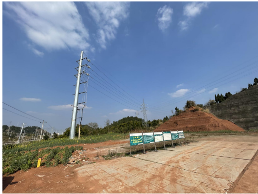
变电站四周地形地貌 1
